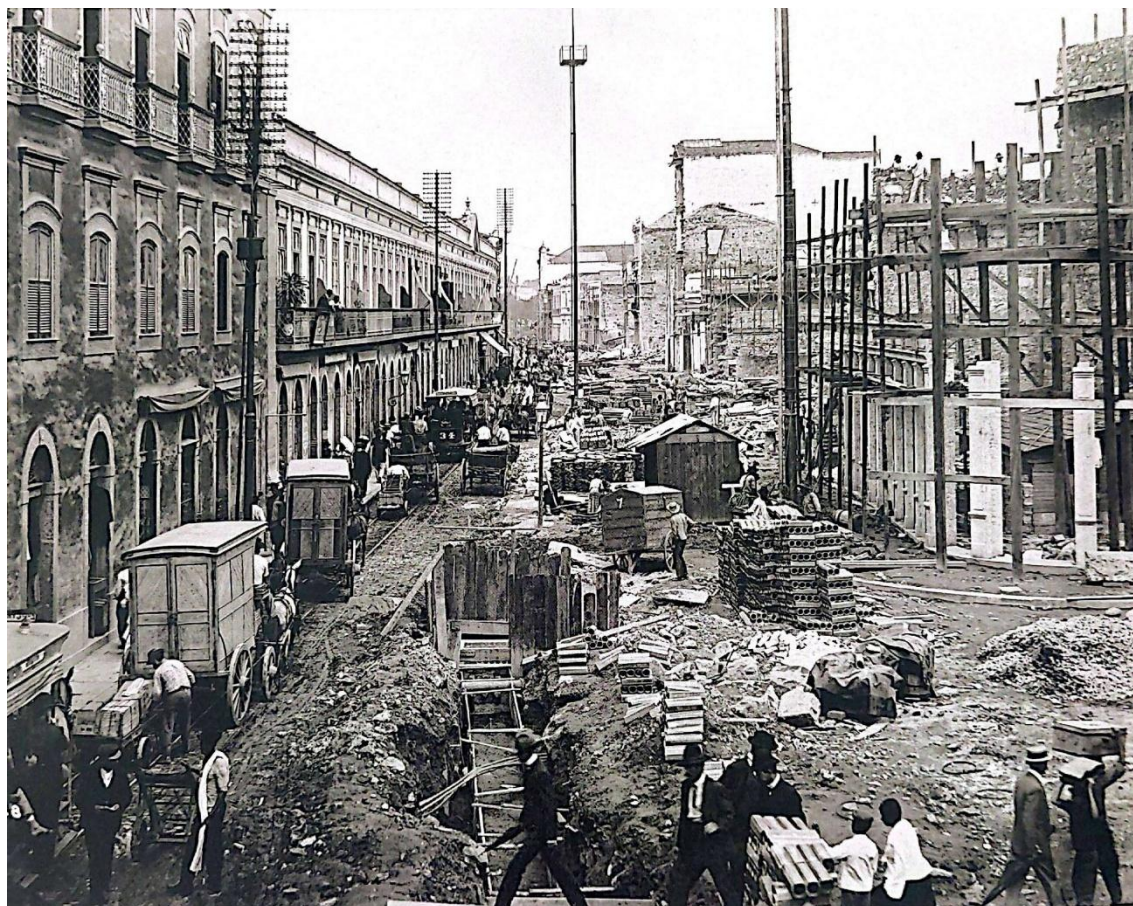
Figura 35 – Rua da Carioca (1905), demolições na reforma Pereira Passos.
