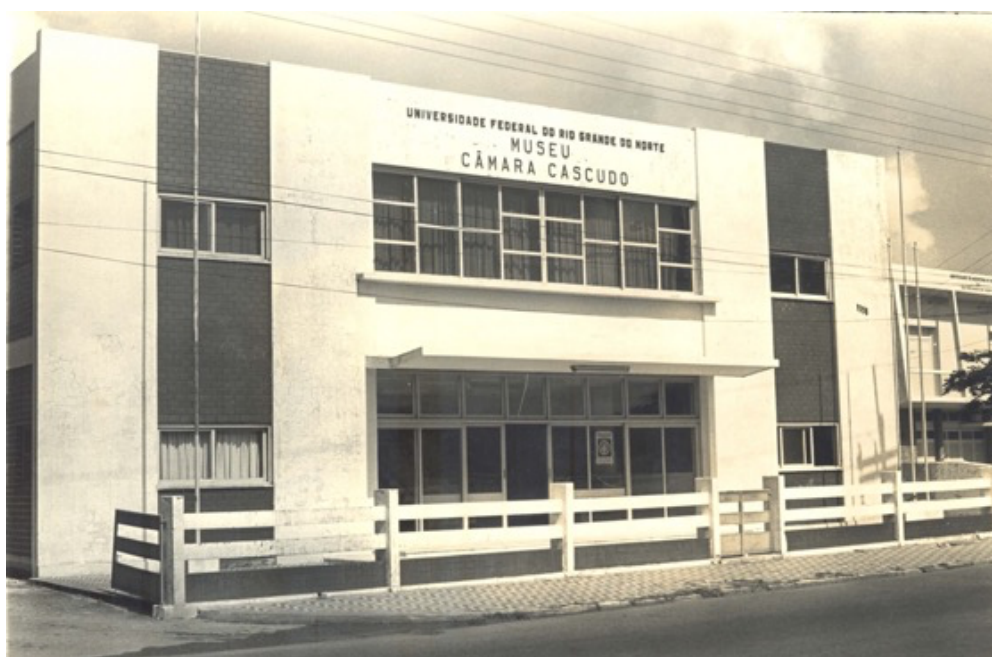
Figura 41 - Prédio do Museu Câmara Cascudo, década de 1970. Fonte: Acervo do Museu Câmara Cascudo (MCC)
