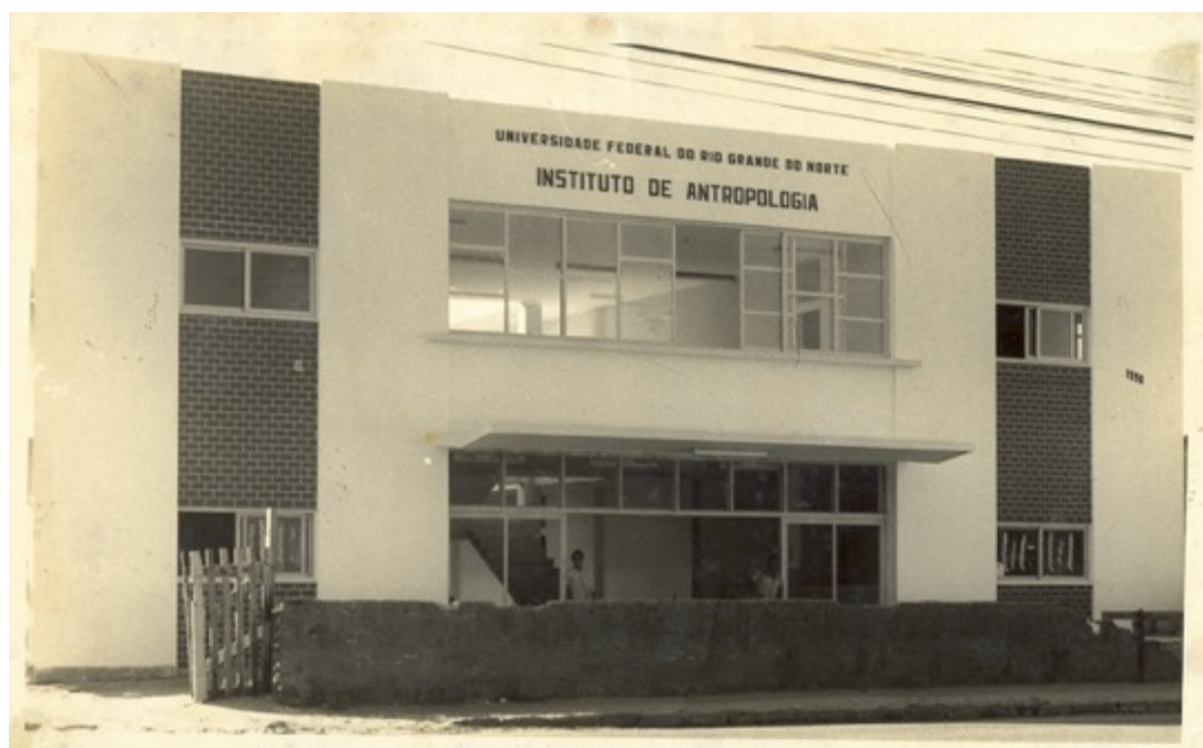
Figura 13 - Novo edifício do Instituto de Antropologia. Década de 1960. Fonte: Acervo do Museu Câmara Cascudo.
