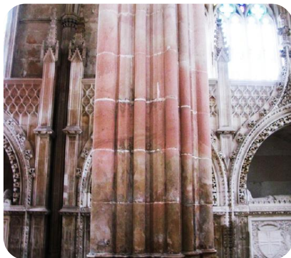
Figura 3: Descoloração rosa das paredes e colunas do Mosteiro da Batalha (Portugal) devido à formação de biofilmes microbianos (adaptado de Silva et al. , 2024)
