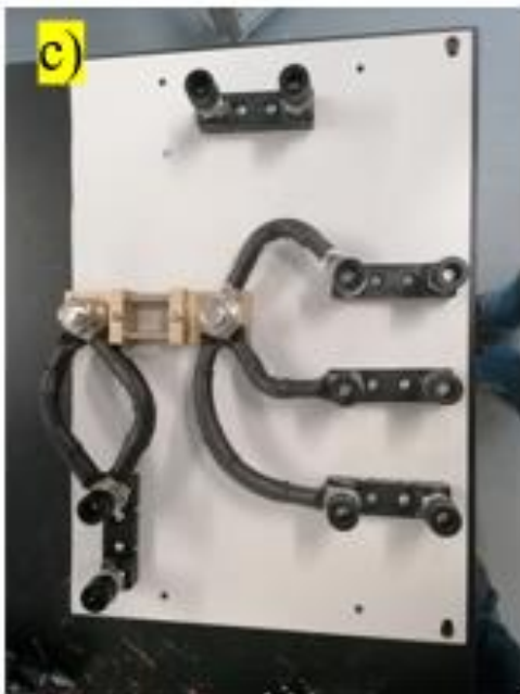
Figura 34 - a) 1ª Fase de Disposição dos Fusíveis no Quadro Elétrico; b) 2ª Fase de Disposição dos Fusíveis nos porta-fusíveis e Terminais de Olhal no Quadro Elétrico; c) Ligação dos cabos elétricos na platina isolante da caixa de transição; d) Finalização da instalação da caixa de transição.
