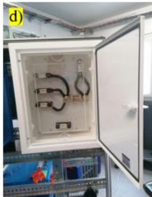
Figura 34 - a) 1ª Fase de Disposição dos Fusíveis no Quadro Elétrico; b) 2ª Fase de Disposição dos Fusíveis nos porta-fusíveis e Terminais de Olhal no Quadro Elétrico; c) Ligação dos cabos elétricos na platina isolante da caixa de transição; d) Finalização da instalação da caixa de transição.
