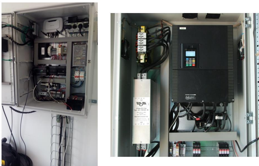
Figura 7 – Autómatos instalados nos demonstradores reais construídos ao abrigo do projeto SolaQua ( Universidad Politécnica de Madrid, s.d. )
