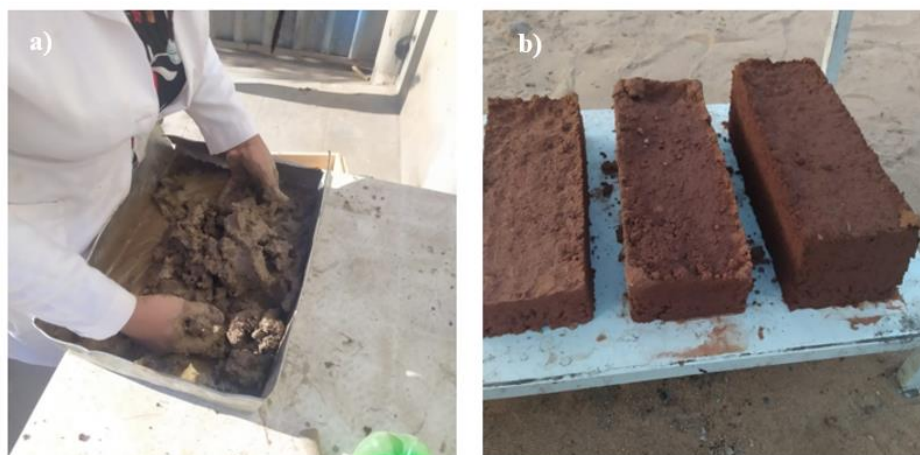
Figura 8. Processo de produção de adobes: a) Mistura do material; b) Adobes expostos ao sol para secar.
