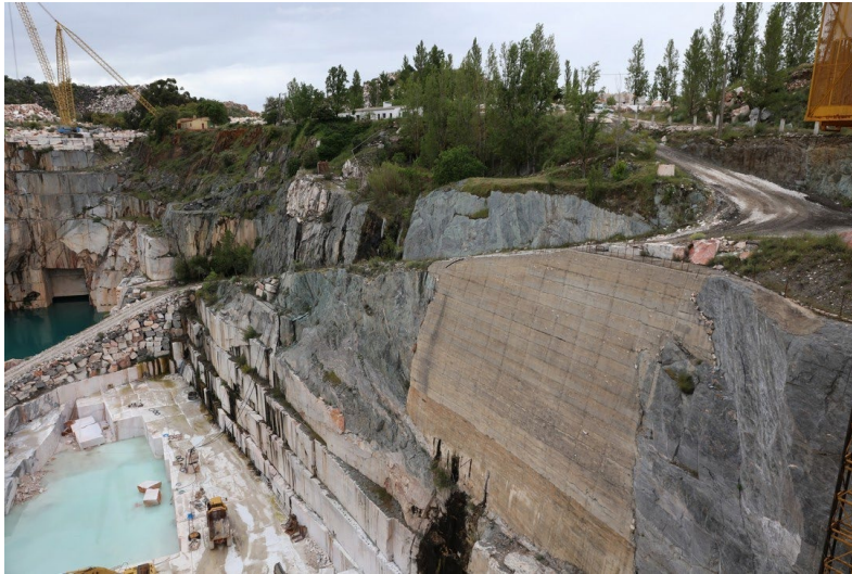
Figura 3 - Aspeto geral do Talude NE.
