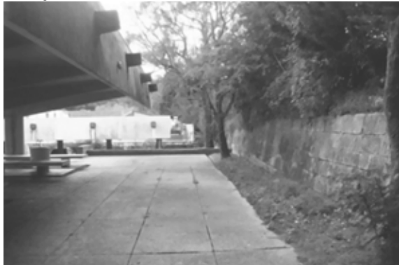
fig. 068 • Muro de contención, retícula del pavimento, vegetación, pilares, cubierta, y los balcones para la venta. Autor de la imagen: Tiago Vieira.
