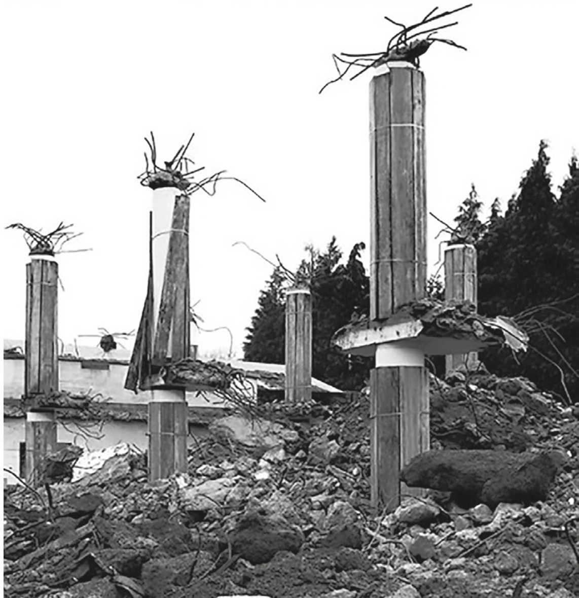
fig. 079 - Demolición de la cubierta del Mercado Municipal do Carandá. Autor de la imagen: Luis Ferreira Alves.
