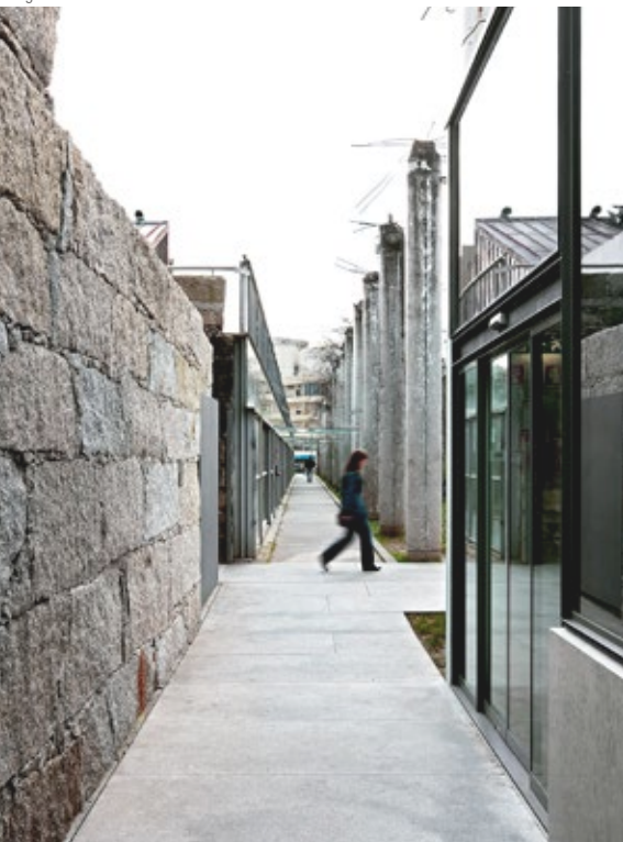
fig. 092 - Circulación longitudinal, muro de piedra, y pilares del Mercado Cultural do Carandá. Autor de la imagen: Luis Ferreira Alves.
