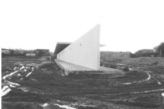
fig. 073 - Construcción del Mercado Municipal do Carandá (1980-1984). Autor de la imagen: Desconocido.
