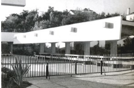
fig. 064 - Pilares y cubierta en forma de alas de uno de los volúmenes del mercado. Autor de la imagen: Desconocido.
