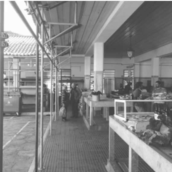
fig. 047 - Andamios en la cubierta del mercado, 2018. Imagen: Realizada por el autor.
