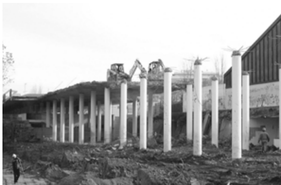
fig. 080 - Demolición de la cubierta del Mercado Municipal do Carandá. Autor de la imagen: Manuel Magalhães.
