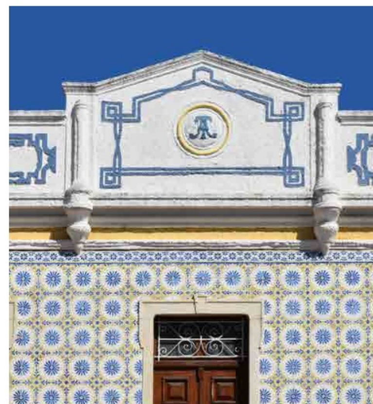
[Figura 153] Barreiras Brancas #09.06.13 Fotografia: autores
