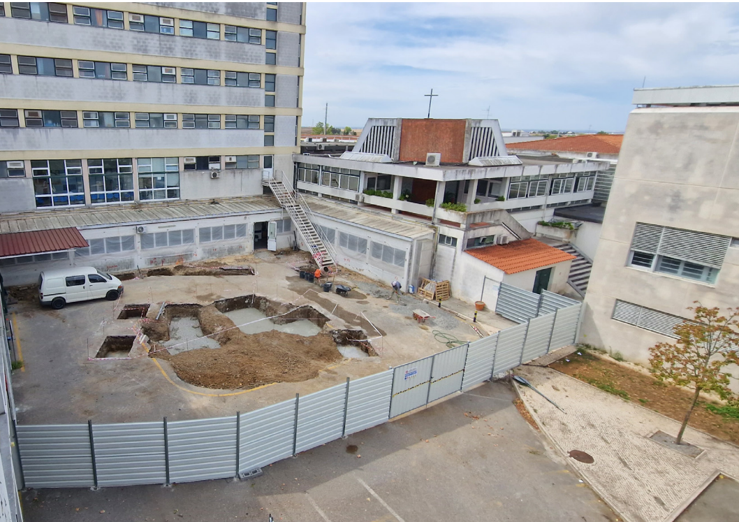
66 - 68. Início da obra, betão de limpeza e betonagem das fundações
