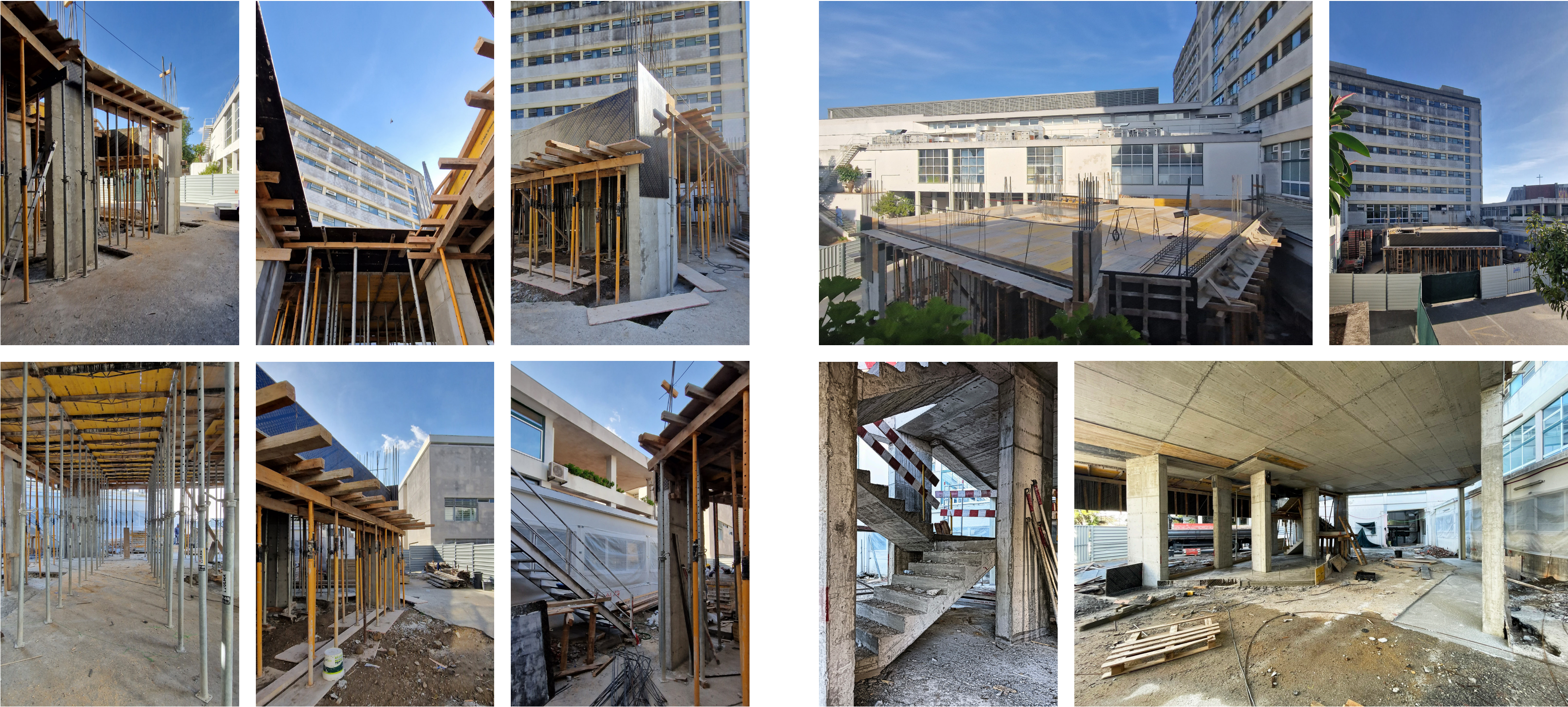
73 - 82. Cofragem e betonagem da laje do 1º piso
