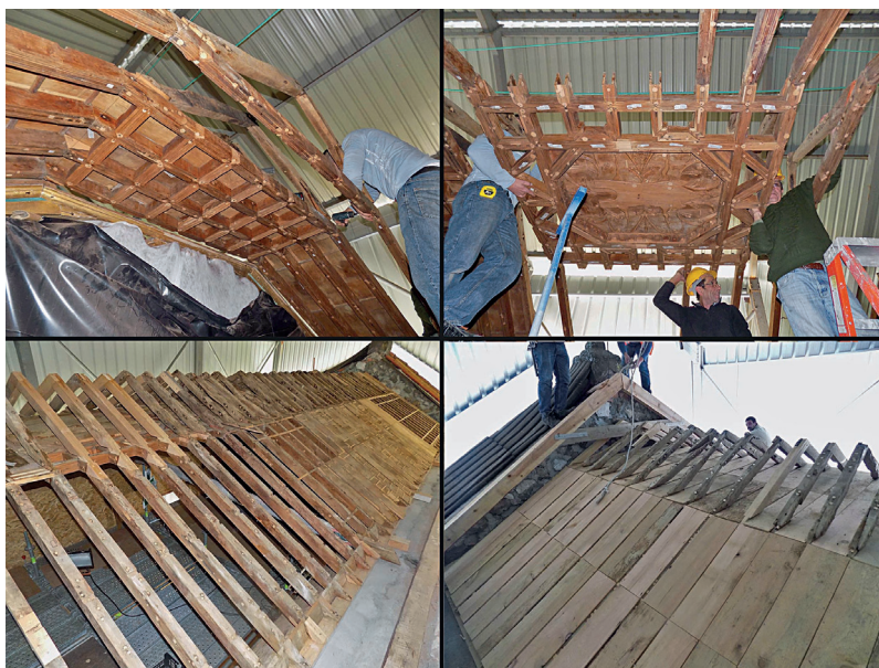
Fig. 7 – Montagem do teto em alfarge (ACROARTE)
