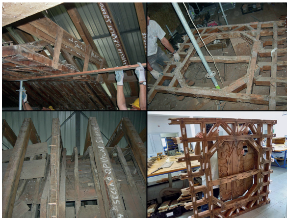
Fig. 5 – Desmontagem do teto em alfarge (ACROARTE).
