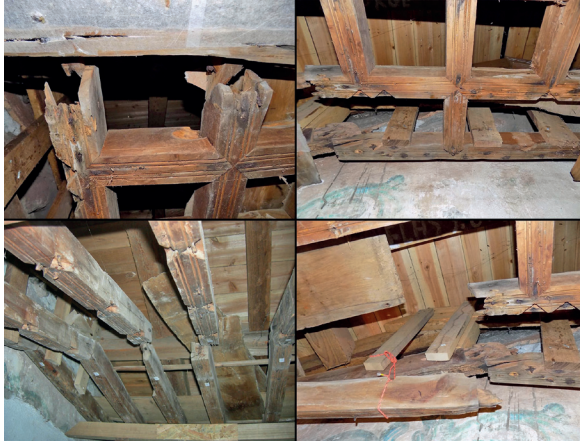
Fig. 3 – Estado de conservação da estrutura do teto em alfarge (ACROARTE).
