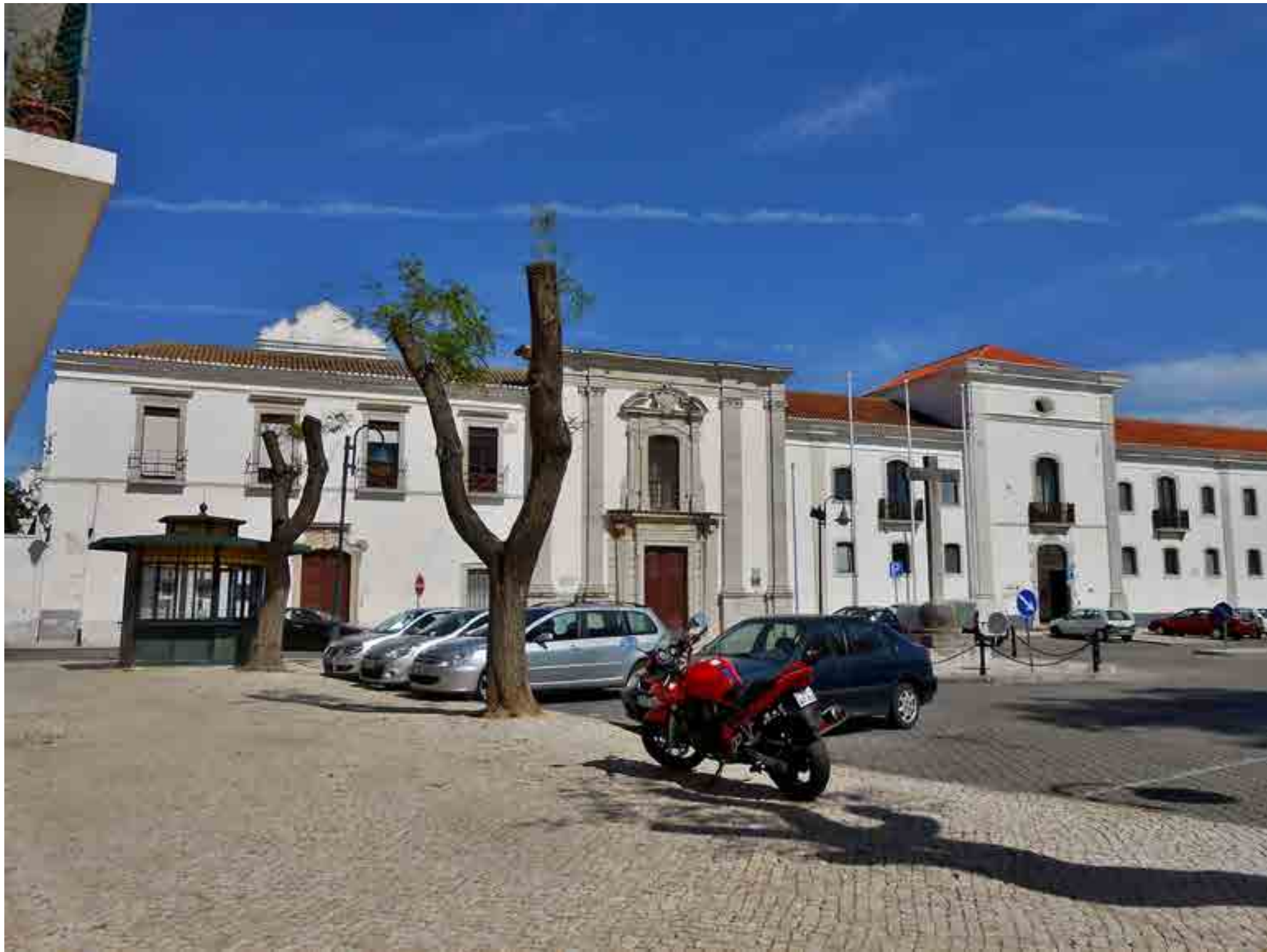
Fig. 103 - Convento de Nossa Senhora do Bom Sucesso - Vista geral de poente
