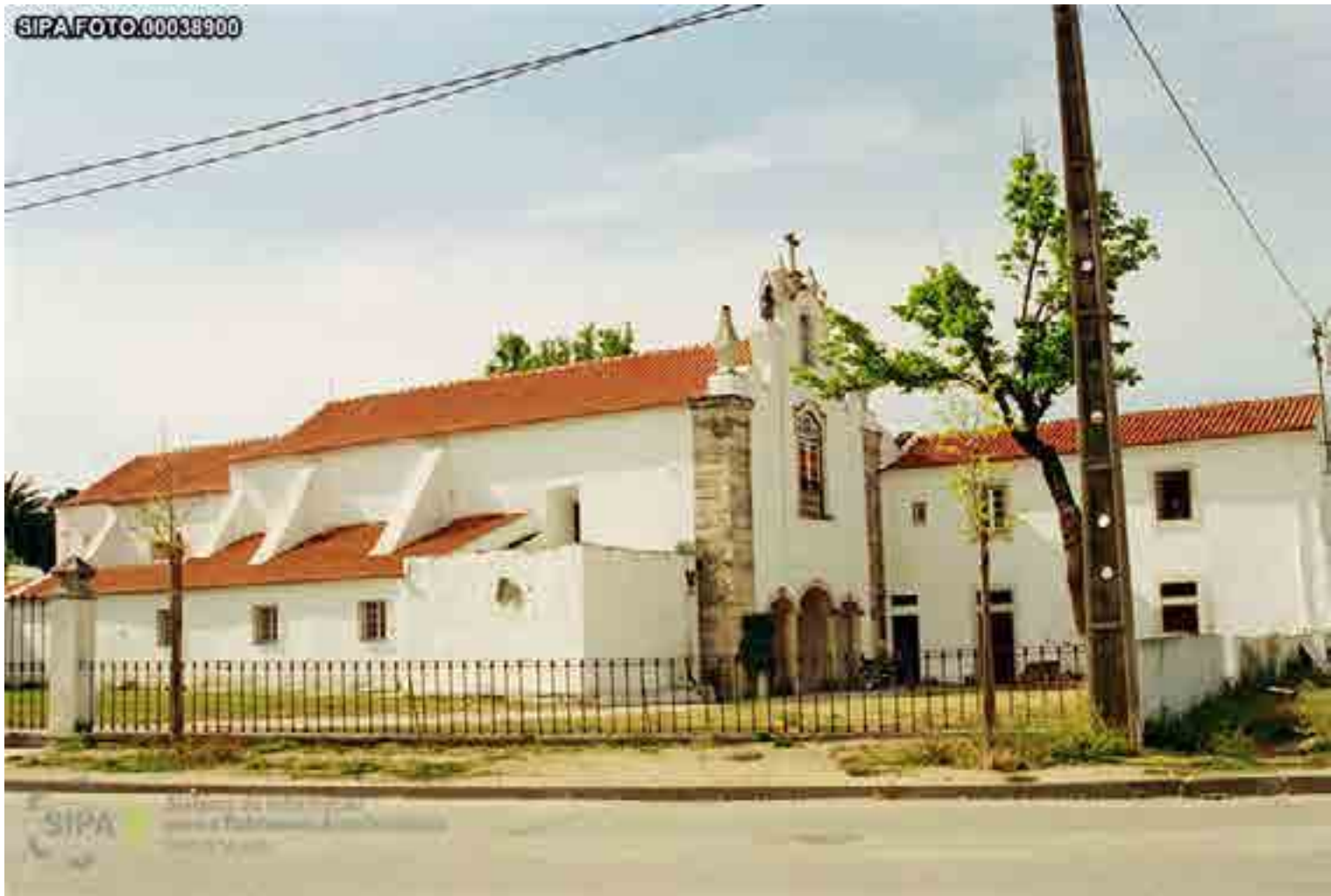
Fig. 51 - Fachada da Igreja do Convento Santo António de Torres Novas Fonte: ©SIPA
