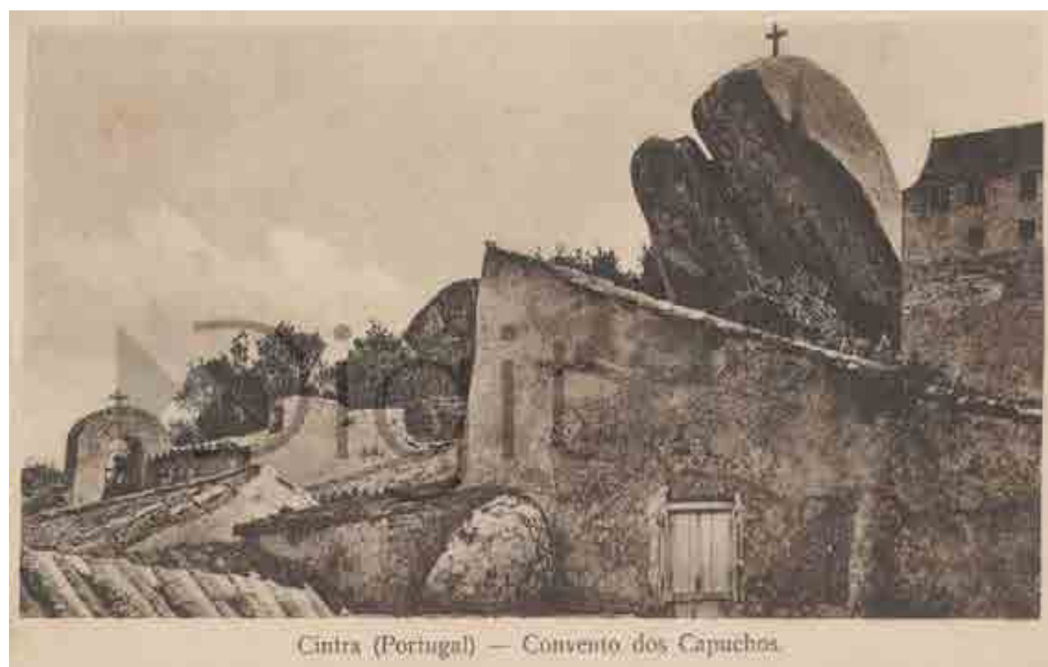
Fig. 134 - Vista parcial do Convento de Santa Cruz da Serra de Sintra
