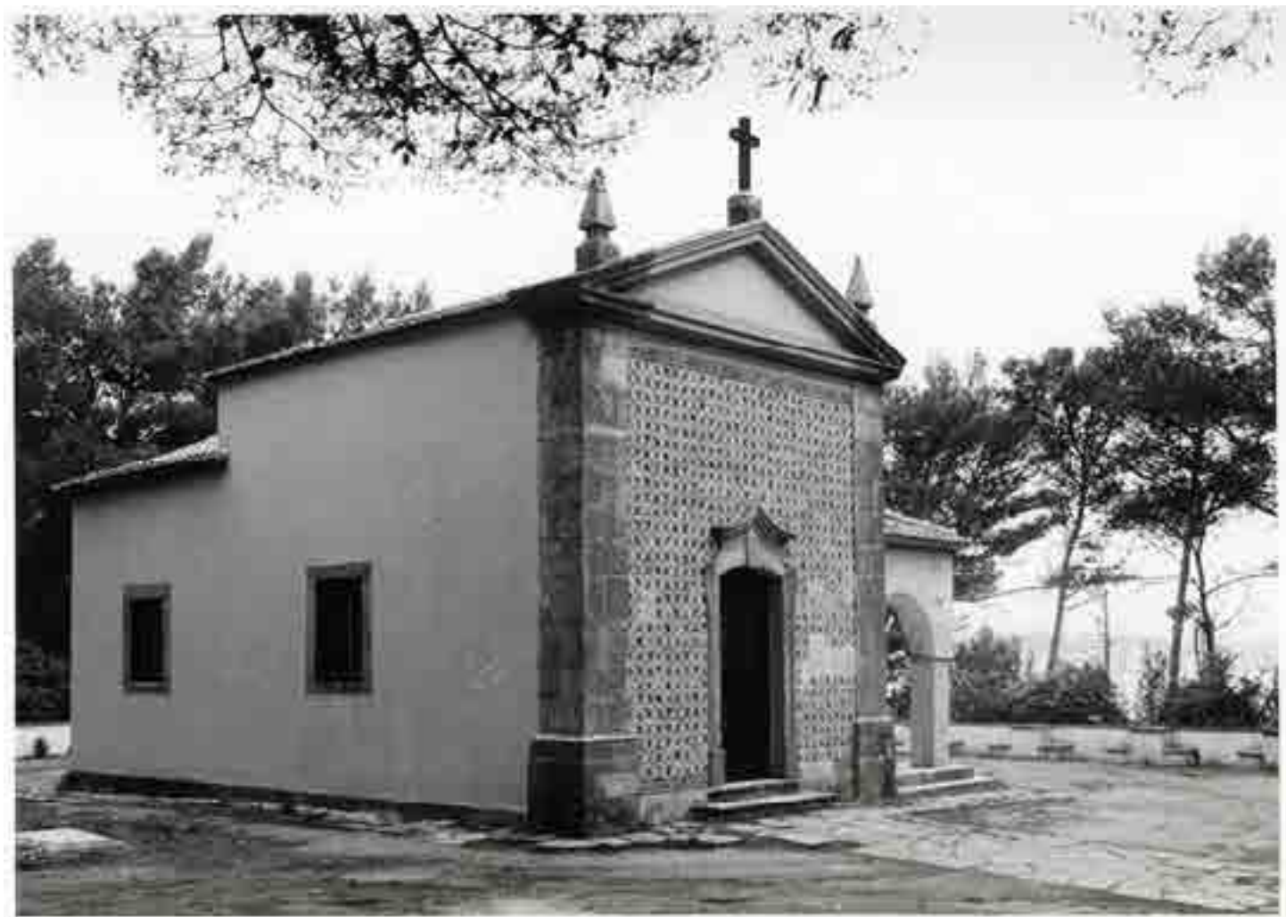
Fig. 54 - Capela do Convento da Nossa Senhora da Boa Viagem Fonte: ©Serviço de Arquivo Municipal. Coleção Património Arquitetónico do Concelho de Oeiras/008, n.º 156. Data: 1986
