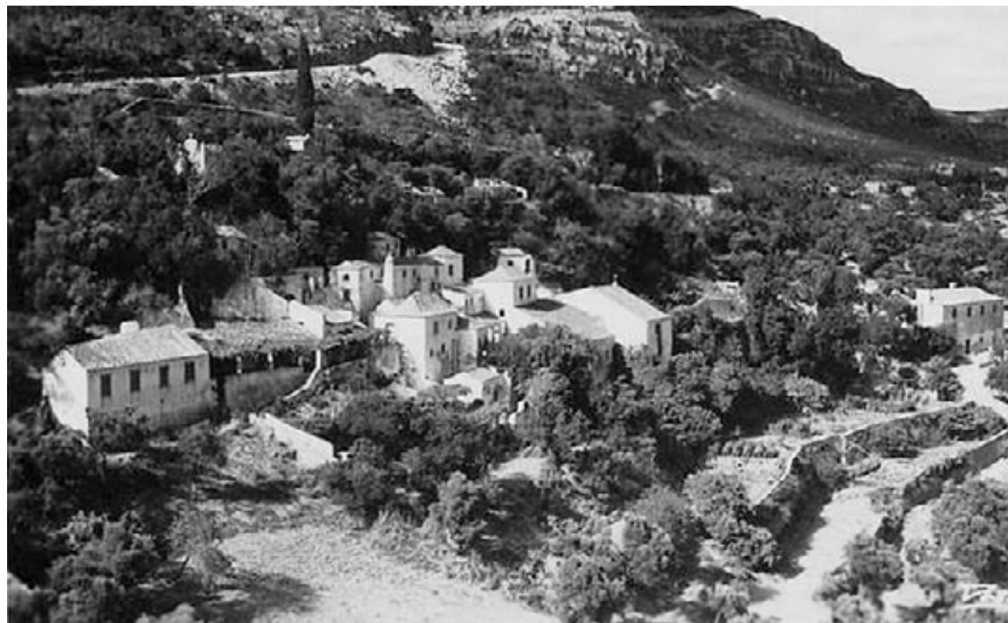
Fig. 2 - Convento Santa Maria da Arrábida
