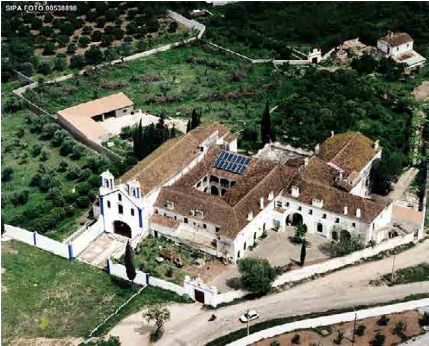
Fig. 61 - Convento de Nossa Senhora da Piedade de Vila Viçosa Fonte: ©SIPA
