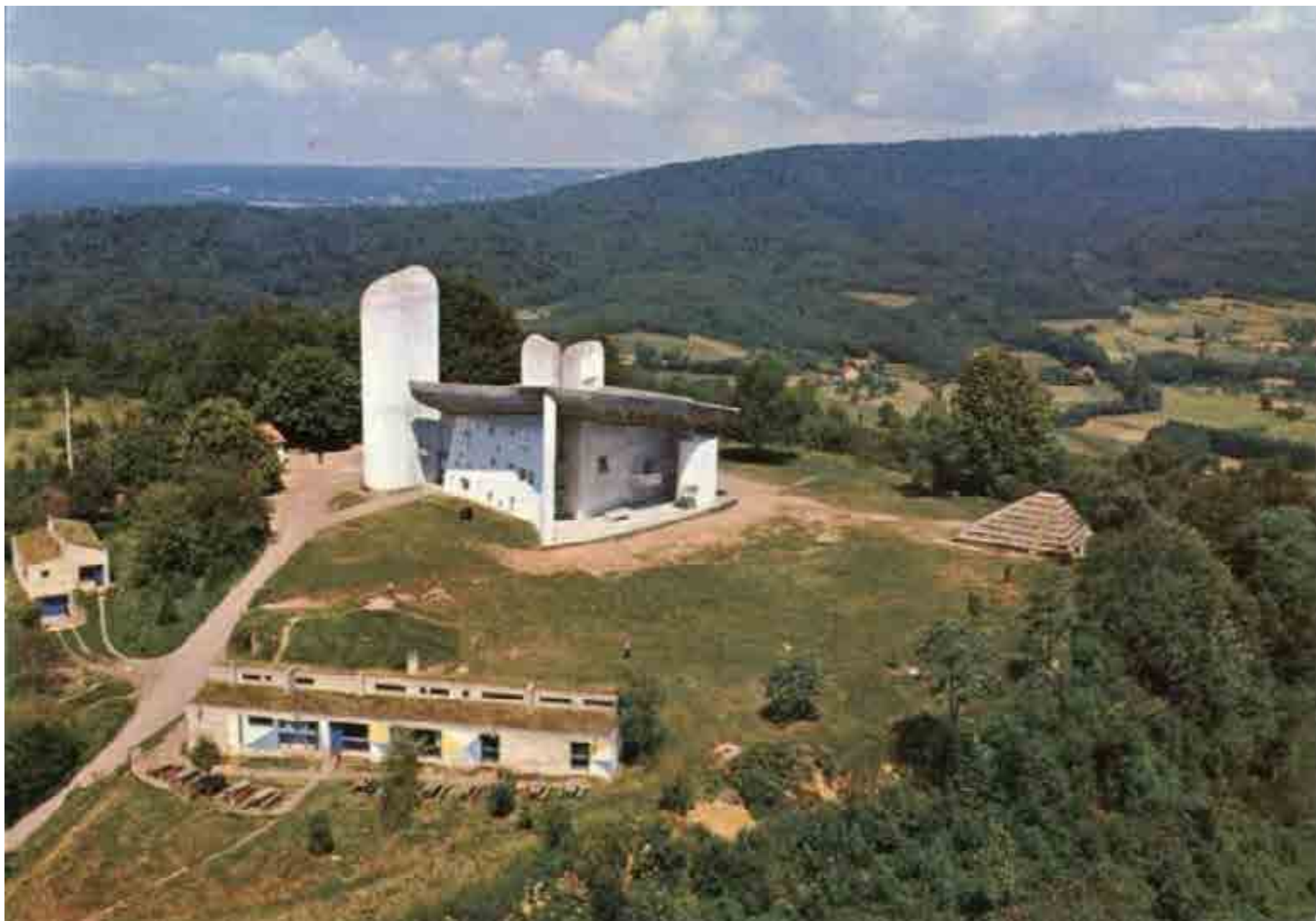
Fig. 84 - Vista aérea da colina onde encontra-se a Capela Notre Dame
