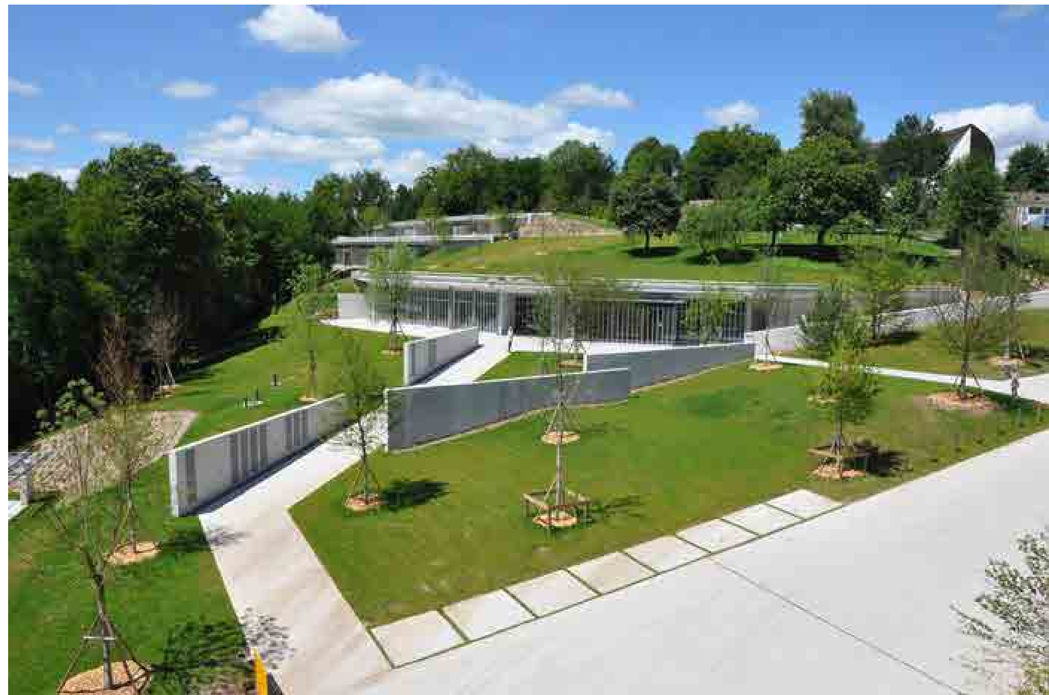
Fig. 89 - Vista geral da portaria
