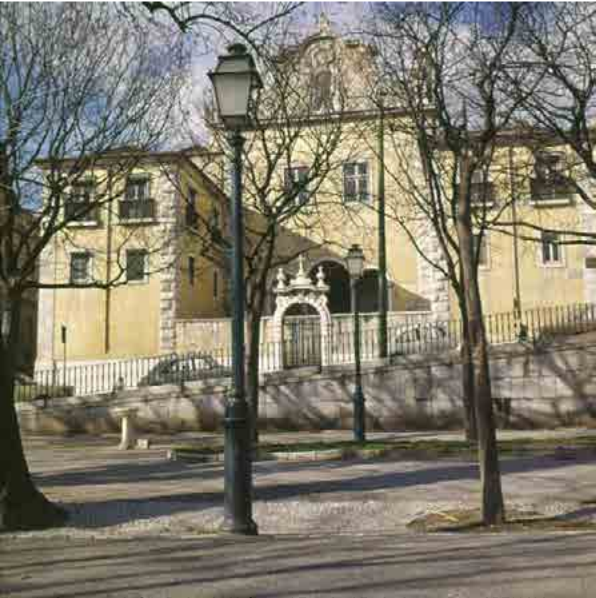
Fig. 58 - Convento de São Pedro de Alcântara | Exterior | Fachada nascente. ART031914 Fonte: ©CML | DMC | Arquivo Municipal de Lisboa
