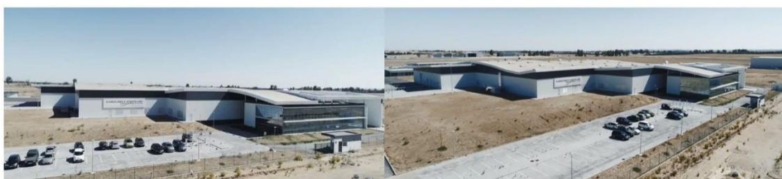
Figura n.º 7: Imagem Aérea do Espaço Físico da Mecachrome Aeronáutica.
