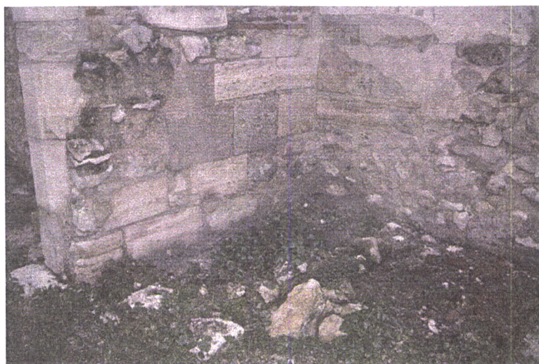
Fig. 5.4 – Início da nave. Parede que enforma o arco triunfal, do lado sul. Observa-se a tipologia da pedra que constitui a alvenaria. 1996.
