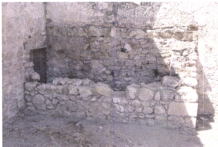
Fig. 3.39 – Muro que circunda o pequeno corredor. À esquerda o vão de acesso à capela lateral da Igreja e em frente o empedrado que entaipa o portal do alçado sul da capela-mor. 1996.
