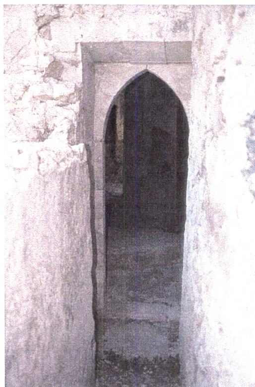
Fig. 4.17 – Exterior da capela da Igreja das Virtudes. 1996. Vista do portal gótico. No pavimento observa-se a soleira. Em primeiro plano, à esquerda, o muro que circunda o pequeno corredor.
