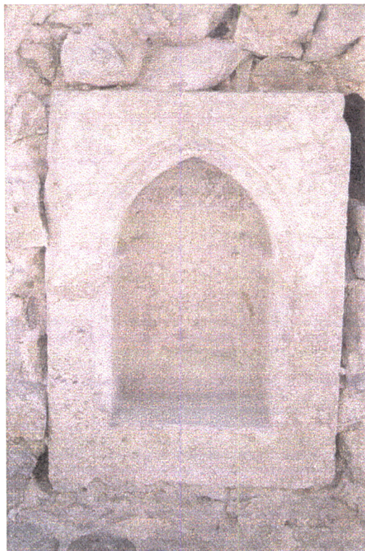
Fig. 3.13 – Nicho com duas marcas gliptográficas na parte superior.
