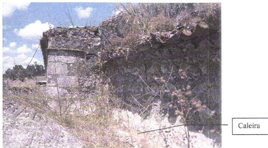
Fig. 5.8 – Aplicação da telha de canudo no beirado da capela-mor e na caleira. 1996.
