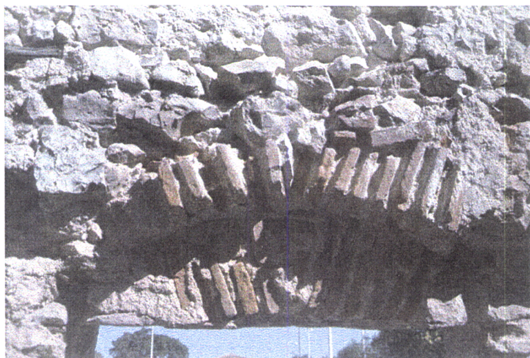
Fig. 5.5 – Tijolo artesanal como elemento estrutural de um vão. 1996.
