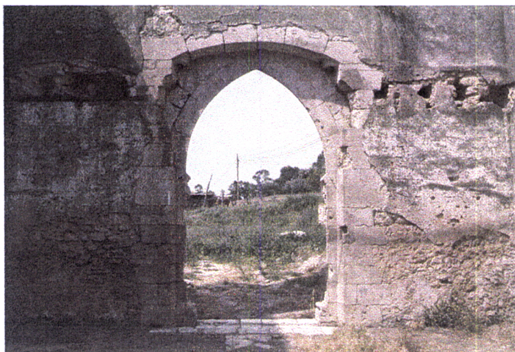
Fig. 3.30 – Interior da Igreja do Convento de N. S. das Virtudes (Azambuja). Maio, 1996. Portal principal.
