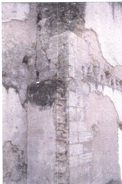
Fig. 4.14 – Exterior da Igreja das Virtudes. 1996. Observação do encosto entre a parede da capela-mor, à esquerda, e a parede da nave, à direita (lado norte).
