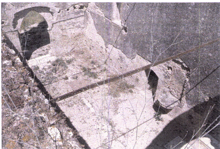
Fig. 3.23 – Vista de um tirante colocado no topo da nave. 1996.
