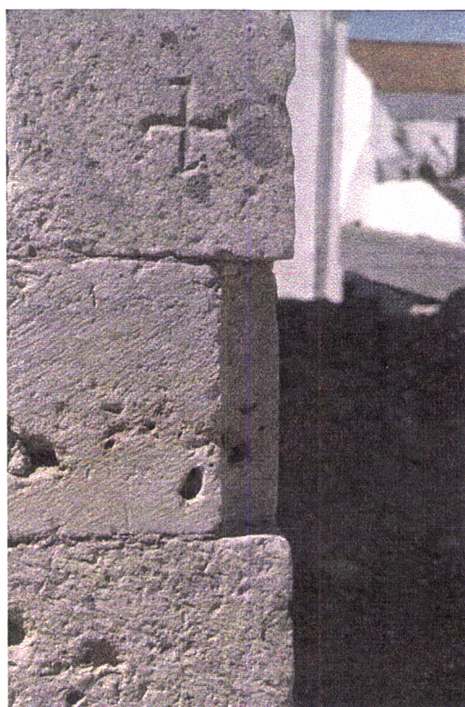
Fig. 4.12 –Observam-se três cunhais no alçado nascente da Igreja das Virtudes (1º plano da fotografia). 1995.
