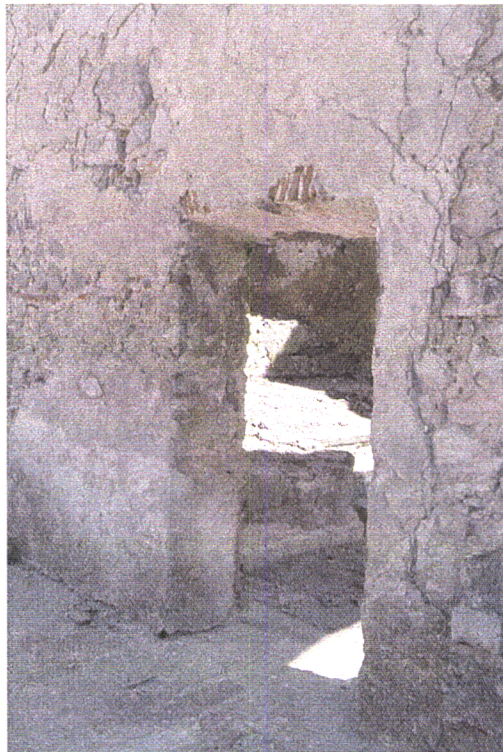
Fig. 3.38 – Vista exterior da porta que foi aberta no alçado norte da capela-mor. Observa-se a verga do vão lateral que foi entaipado. 1996.
