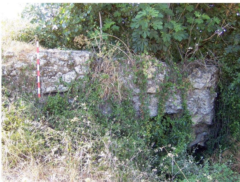
Represa (17.05): imagem de parte do paredão da barragem.
