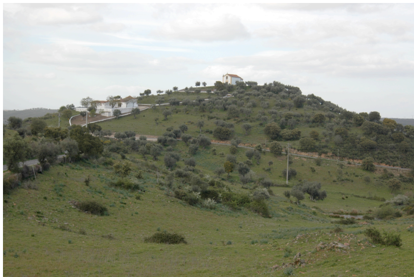
N. Sr. a da Graça (14.14): vista actual do complexo religioso. O templo romano estaria no topo da elevação, sob a actual igreja.
