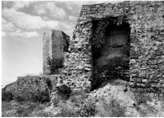
221.Foto DGEMN– taipa revestida por alvenaria de época cristã;
