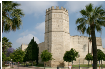
253. muros taipa da alcazaba com albarrã e taipa
