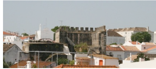
221.Foto DGEMN– taipa revestida por alvenaria de época cristã;
