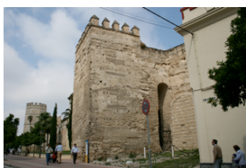
253. muros taipa da alcazaba com albarrã e taipa
