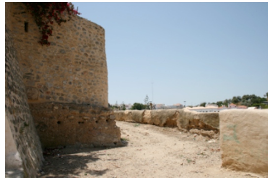
224.detalhe da taipa na base da torre e a barbacã à direita na imagem
