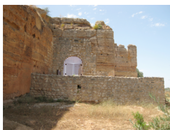
237 entrada em cotovelo protegida por barbacã em alvenaria
