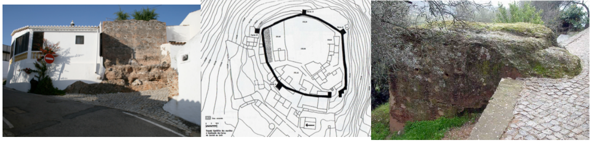
208. Torre em taipa entre casas; 209. planta geral da fortificação(H. Catarino); 210. torre em taipa não restaurada
