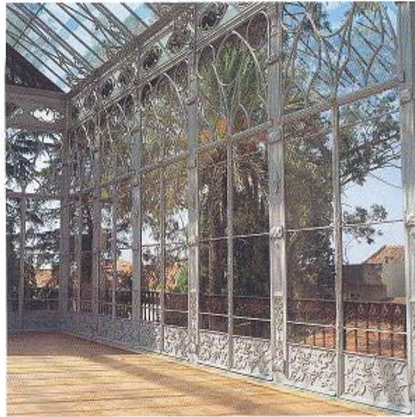
2 e 3. Reposição de transparências no estúdio fotográfico Victor Mestre
