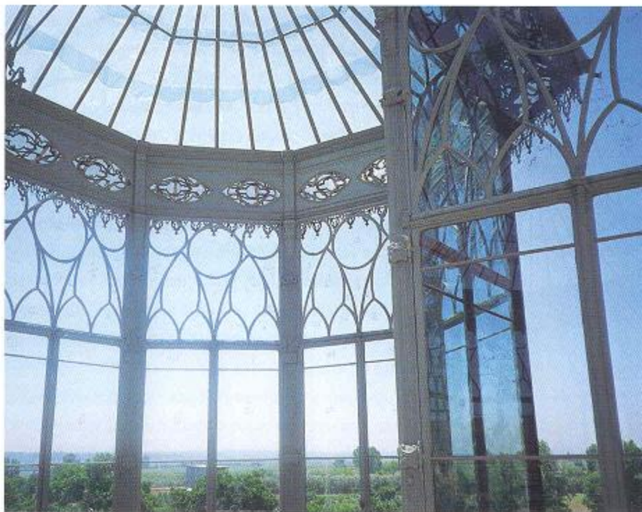
1. Casa-Estúdio Carlos Relvas, fase de obra IPPAR/Maria Romalho
