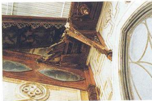
9 e 10. Elementos de madeira danificados A2P
