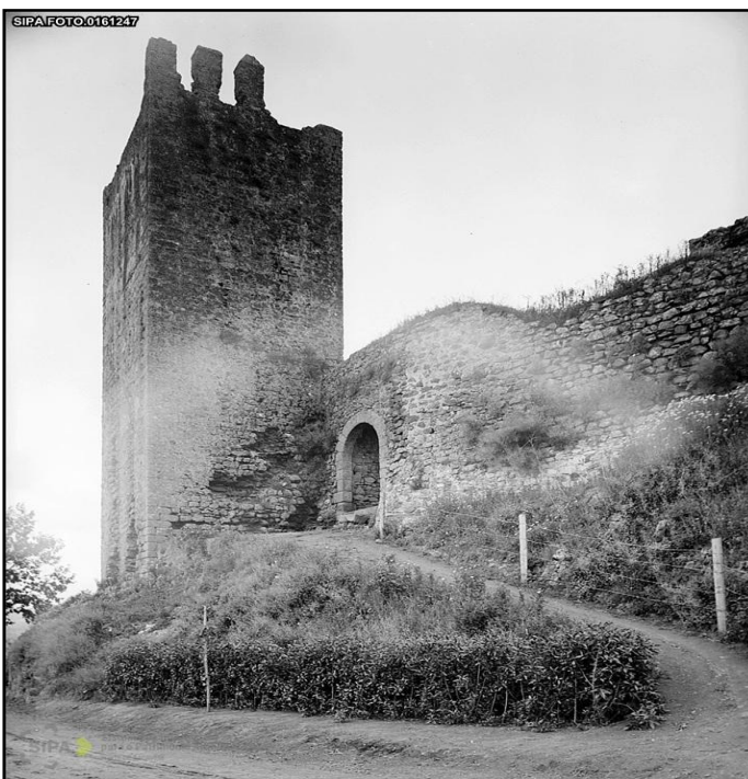
Figura 29 - Torre da Má Hora, antes da realização das obras da década de 40
