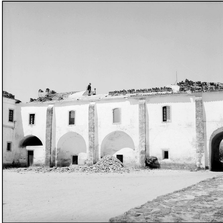
Figura 11 - Obras de substituição de telhados no Convento da Saudação, no Castelo de Montemor-o-Novo – http://www.monumentos.pt – Acesso em: 16/05/2011.
