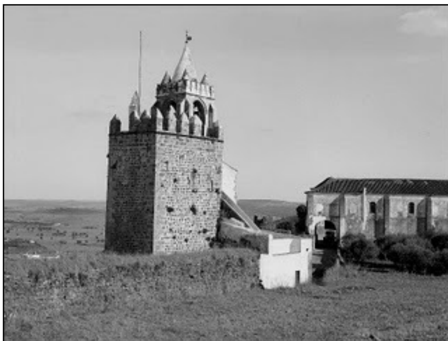
Figura 1 – Torre do Relógio antes das obras da década de 40 – www.monumentos.pt – Acesso em: 17/05/2011.
