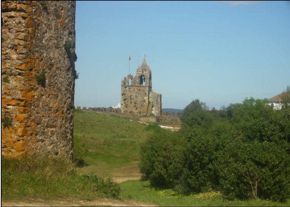
Figura 48 – Torre do Relógio, vista do interior do Castelo de Montemor-o-Novo - (Ana Abelha – 2011)
