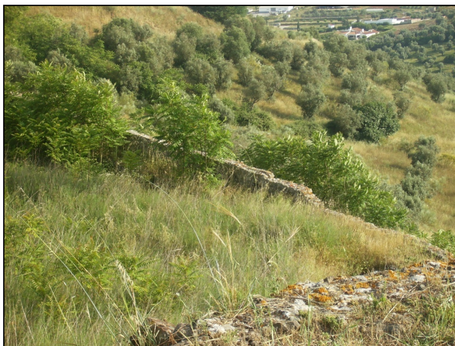
Figura 41 - Trecho da muralha oeste muito destruído e praticamente destruído do Castelo de Montemor-o-Novo - (Ana Abelha – 2011)
