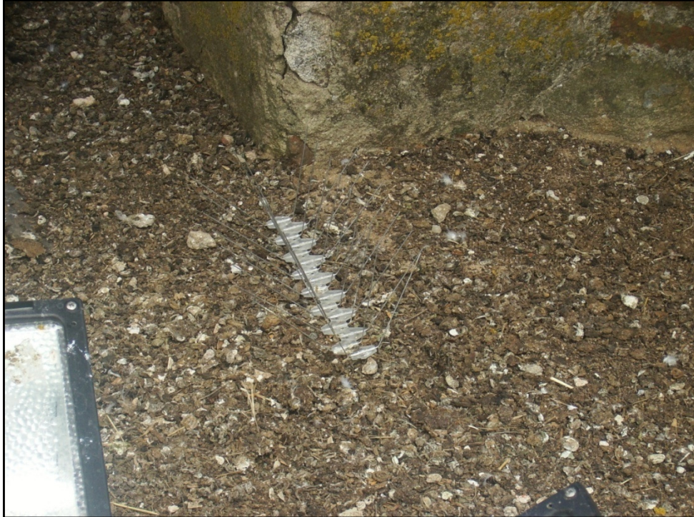
Figura 59 - Dissuasores de Pombos na Torre do Relógio – Sistema Avipoint (Ana Abelha – 2011)
