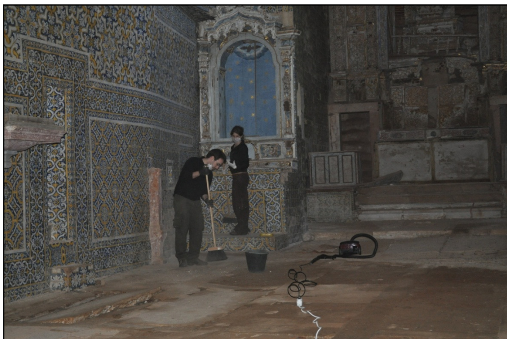
Figura 114 – Trabalhos de Limpeza do Coro Baixo da Igreja do Convento da Saudação
