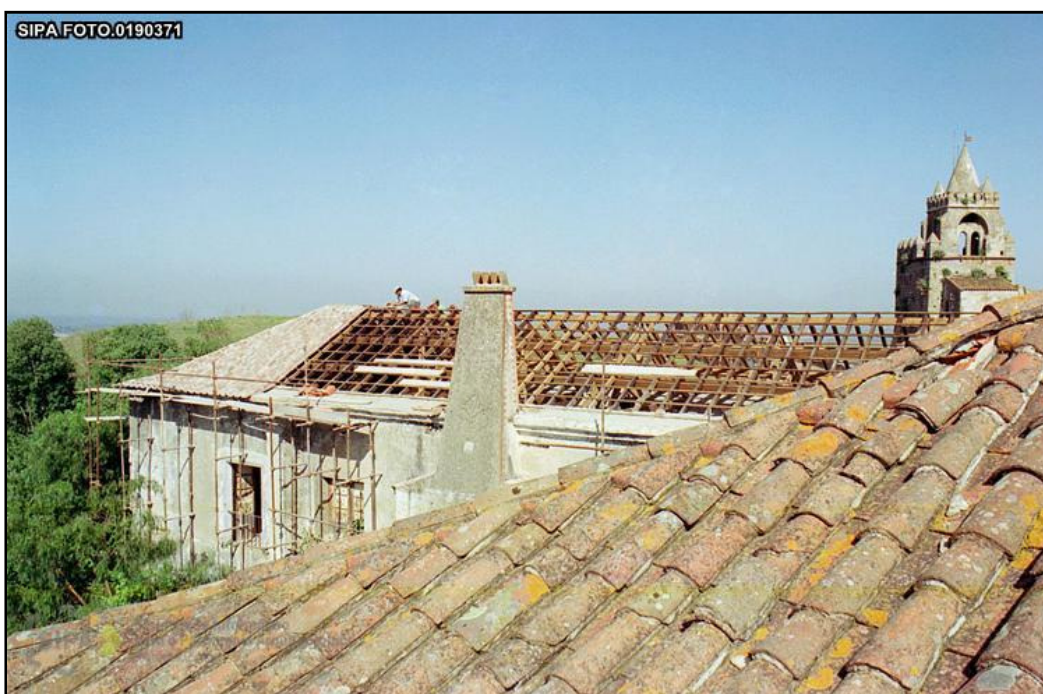
Figura 37 - Realização de obras no telhado do Convento da Saudação - 1996
