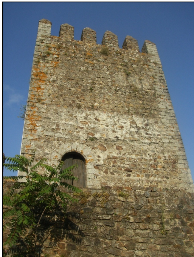
Figura 53 – Torre da Má Hora, Castelo de Montemor-o-Novo - (Ana Abelha – 2011)
