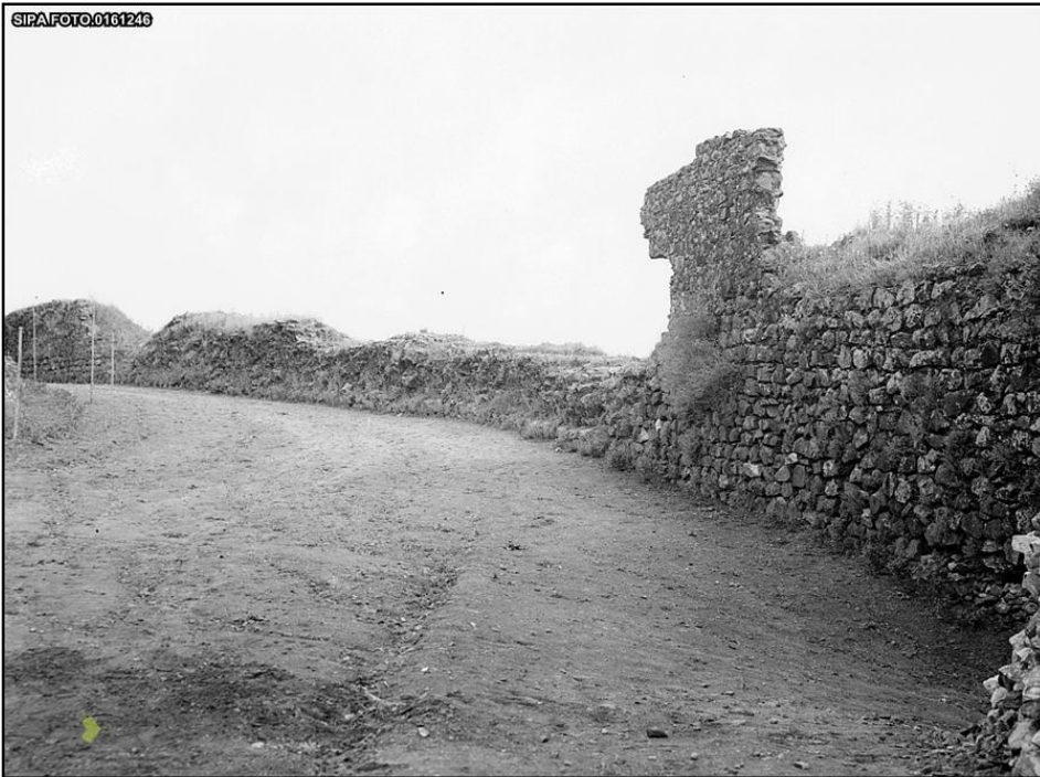
Figura 32 - Pano da muralha norte do Castelo de Montemor-o-Novo, antes da realização das obras da década de 40
