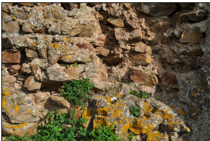
Figura 26 – Local de recolha da Amostra 15 – Argamassa do Paço dos Alcaides, Torreão Nordeste
