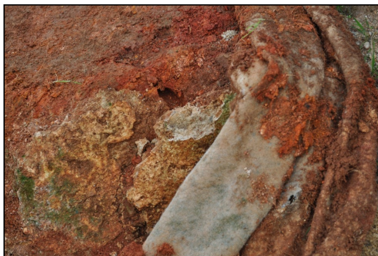
Figura 14 – Local de recolha da Amostra 7 – Argamassa da estrutura em taipa
