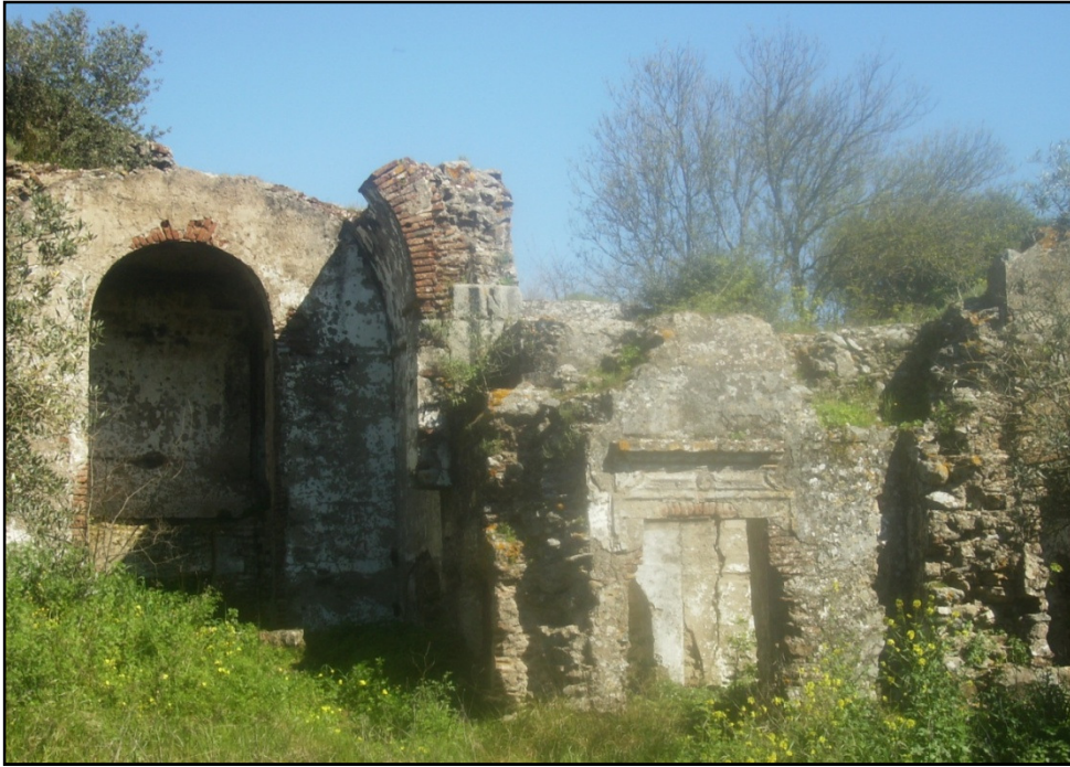
Figura 77 – Altar e Sácristia da Igreja de Nossa Senhora do Bispo, Castelo de Montemor-o-Novo - (Ana Abelha – 2011)
