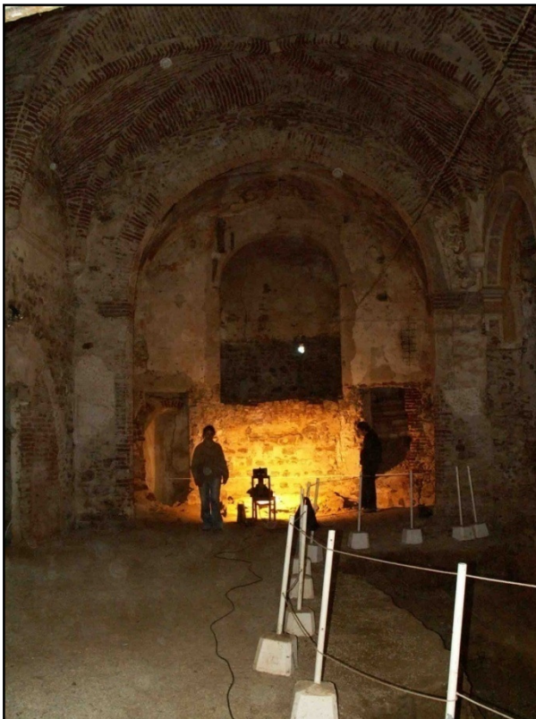
Figura 70 – Interior da Igreja de São Tiago antes da realização das obras de recuperação, Castelo de Montemor-o-Novo - 2004
