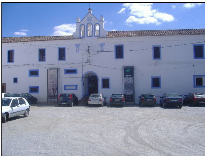
Figura 35 - Frontaria e portaria do Convento da Saudação (Ana Abelha – 2011)
