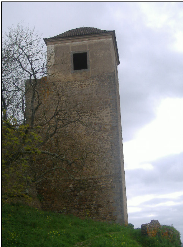
Figura 55 – Torre do Anjo vista do exterior, Castelo de Montemor-o-Novo - (Ana Abelha – 2011)
