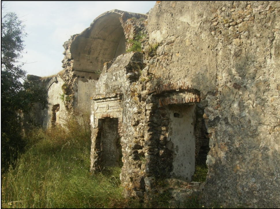
Figura 75 – Altar e Sácristia da Igreja de Nossa Senhora do Bispo, Castelo de Montemor-o-Novo - (Ana Abelha – 2011)
