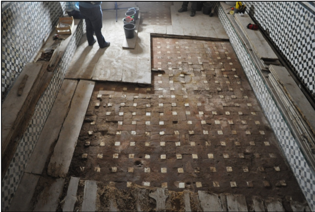
Figura 115 – Trabalhos de Limpeza do Coro Baixo da Igreja do Convento da Saudação
