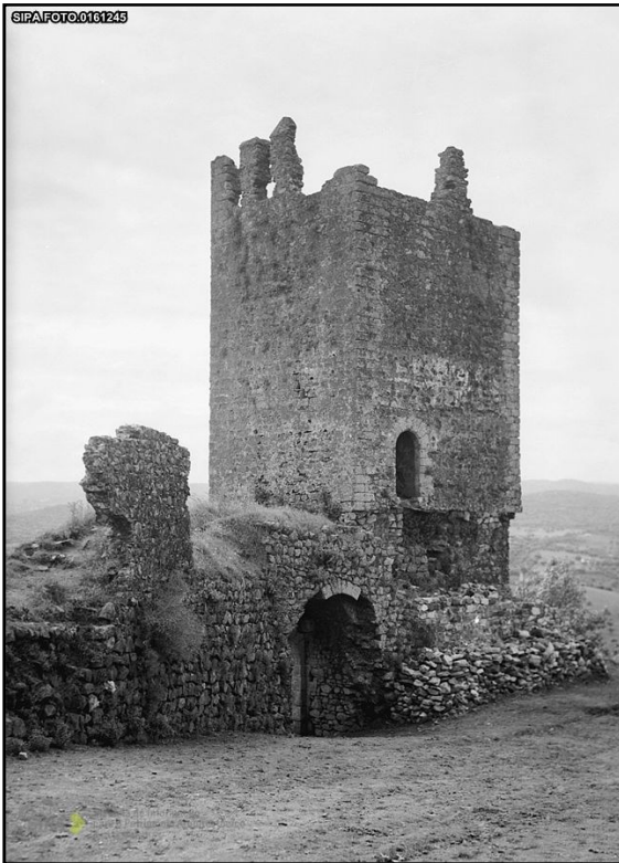
Figura 28 - Torre da Má Hora, antes da realização das obras da década de 40
