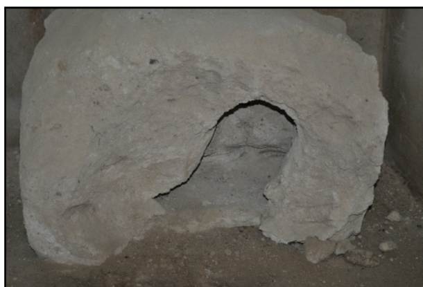
Figura 4 - Amostra 2 – Argamassa da Cripta, sepultura 2
