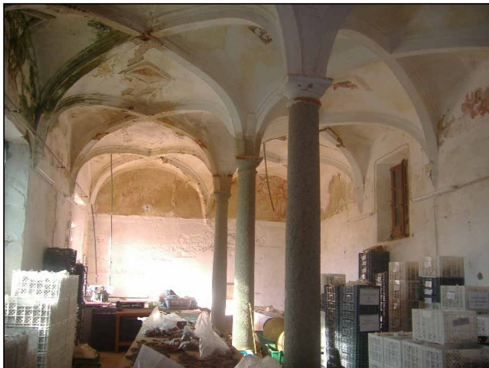
Figura 88 – Sala do Convento da Saudação que serve de depósito de espólio arqueológico do Programa do Castelo, Castelo de Montemor-o-Novo - (Ana Abelha – 2011)
