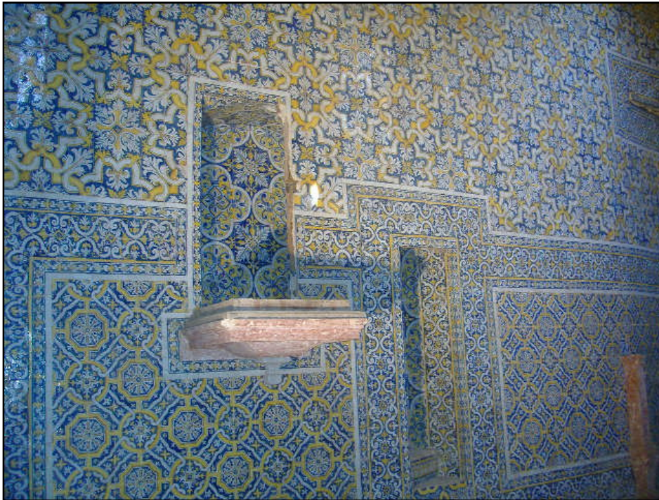
Figura 89 – Parede da Igreja do Convento da Saudação, totalmente forrada a azulejos, Castelo de Montemor-o-Novo - (Ana Abelha – 2011)
