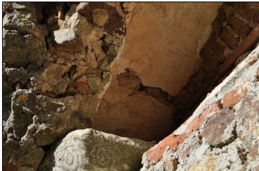
Figura 24 – Local de recolha da Amostra 14 – Argamassa da Igreja de S. João Baptista, Junto ao silhar
