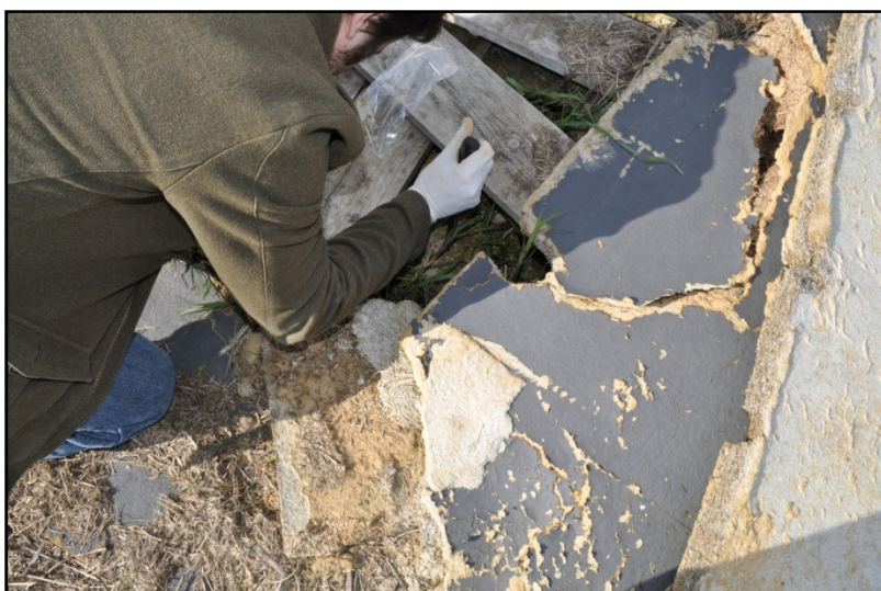
Figura 20 – Local de recolha da Amostra 12 – Argamassa do silo/cisterna, Boca de silo/ cisterna 3
