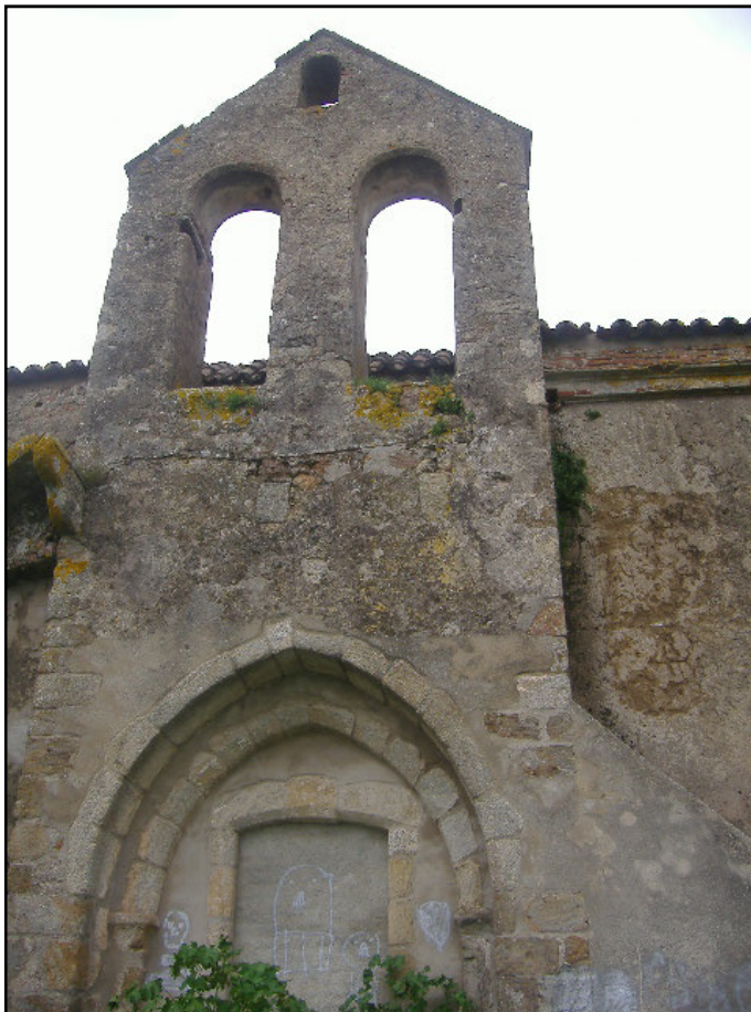
Figura 63 – Campanário e antigo portal sudoeste com arco quebrado da Igreja de São João Baptista, Castelo de Montemor-o-Novo - (Ana Abelha – 2011)
