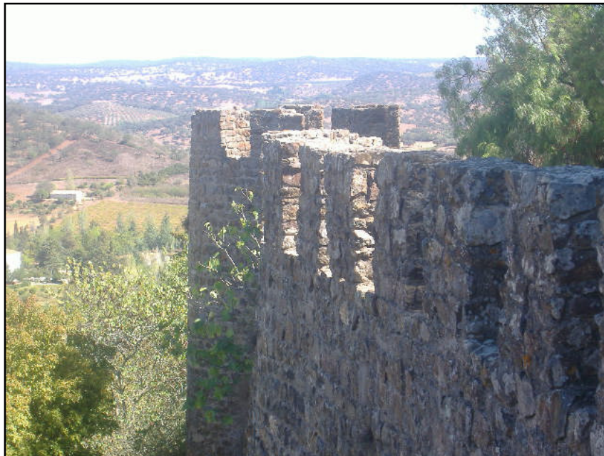
Figura 39 - Promenor de ameias do pano norte da muralha do Castelo de Montemor-o-Novo - (Ana Abelha – 2011)
