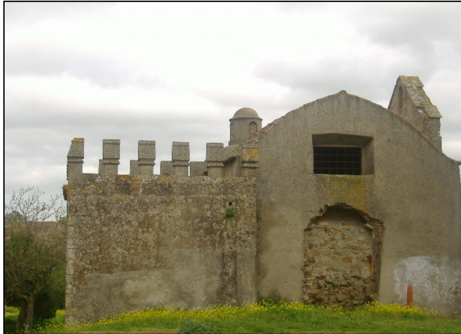
Figura 60 – Antiga entrada entaipada da Igreja de São João Baptista, virada para o Paço dos Alcaides, Castelo de Montemor-o-Novo - (Ana Abelha – 2011)
