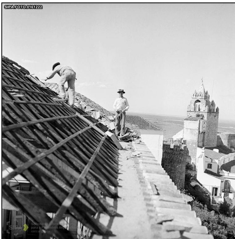
Figura 36 - Realização de obras no telhado do Convento da Saudação - 1957
