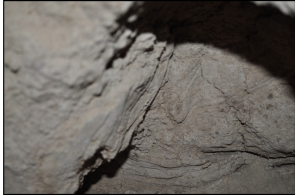
Figura 3 - Amostra 1 – Argamassa da Cripta
