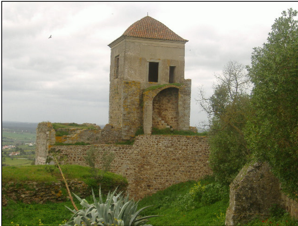
Figura 54 – Torre do Anjo, Castelo de Montemor-o-Novo - (Ana Abelha – 2011)
