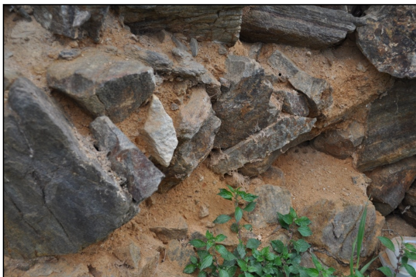
Figura 22 – Local de recolha da Amostra 13 – Argamassa da Muralha Norte, Torreão 4
