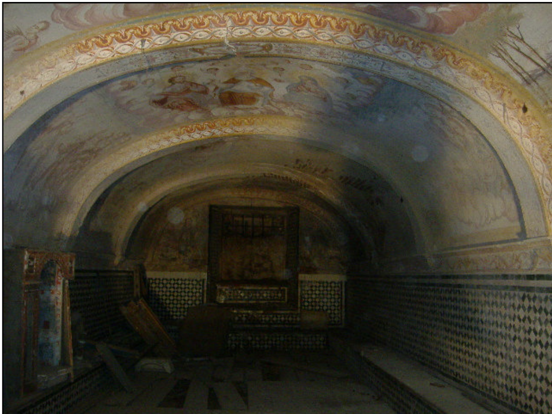
Figura 60 - Coro Baixo do Convento da Saudação antes da limpeza do espaço (Ana Abelha – 2006)
