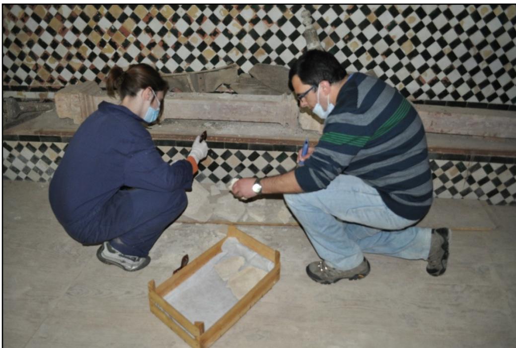
Figura 116 – Trabalhos de Limpeza do Coro Baixo da Igreja do Convento da Saudação
