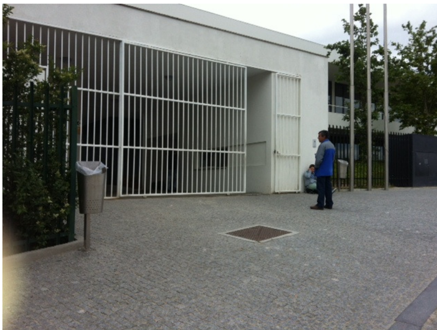
Figura 2 - Fachada principal da Escola EB 2,3/S Cunha Rivara- Arraiolos
