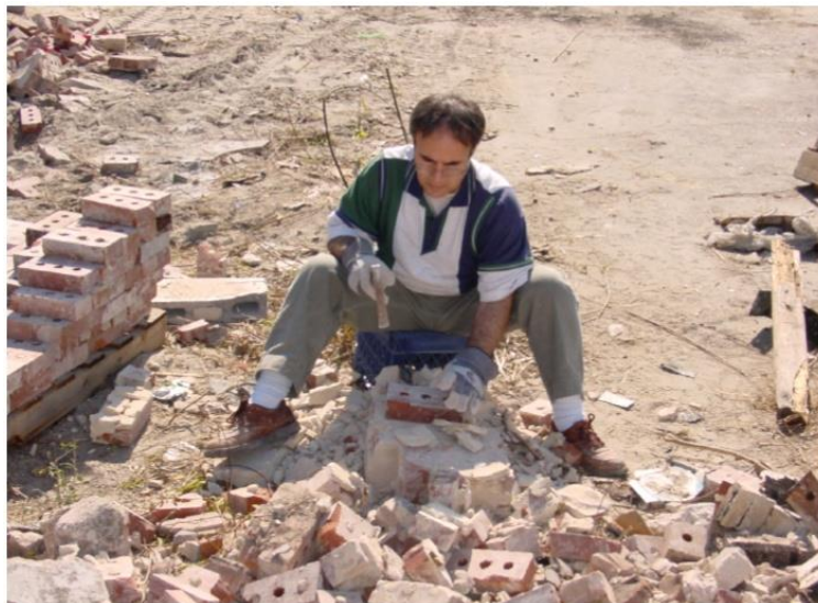
Figura 4.1 - Separação manual dos materiais em obra. [16]
