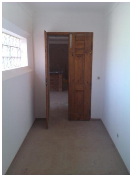
Figura 5.29 - Porta de entrada para a cozinha.
