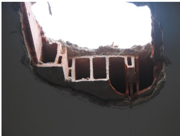
Figura 5.23 - Pormenor da laje do piso 1.
