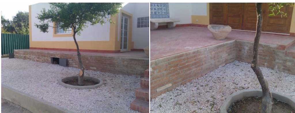
Figura 5.25 e 5.26 – Caixa-de-ar entre cota do terreno e laje do piso 0.
