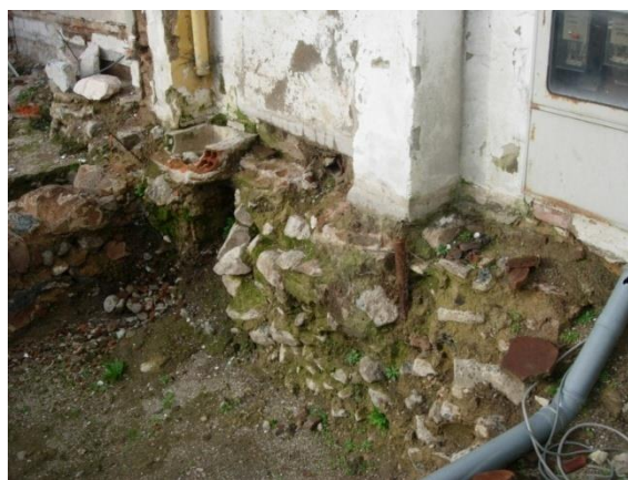
Figura 5.47 - Fundações de um dos edifícios.
