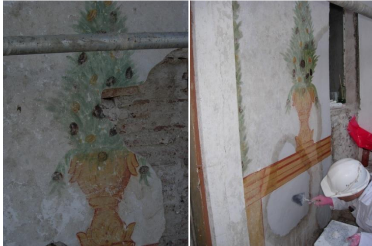
Figura 5.52 e 5.53 - Pintura na fachada antes e durante a intervenção.
