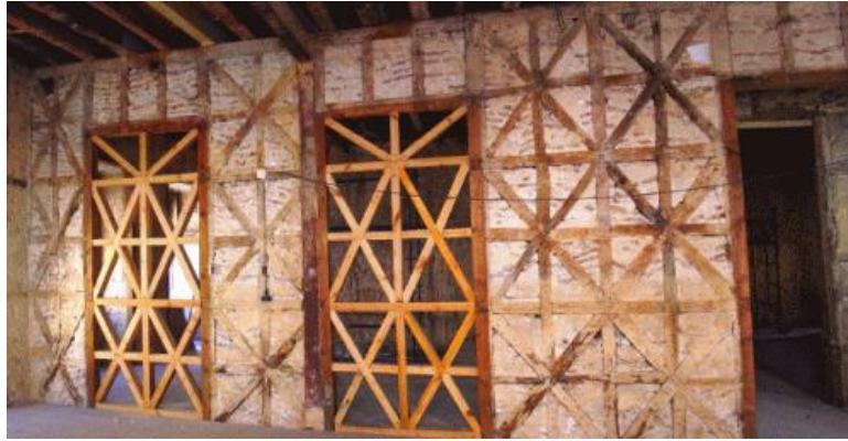
Figura 4.3 - Constituição de uma gaiola pombalina.
