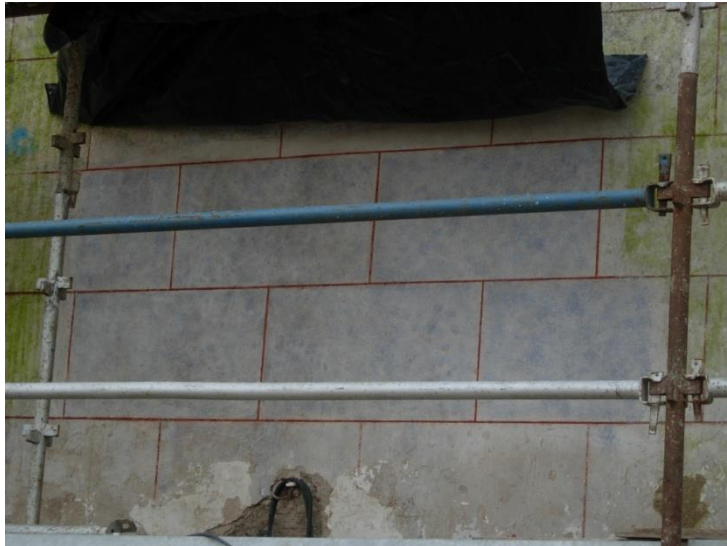
Figura 5.55 - Fachada principal durante os trabalhos de recuperação e limpeza.
