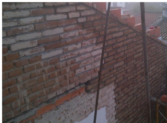
Figura 5.19 - Prolongamento da parede a Nascente.
