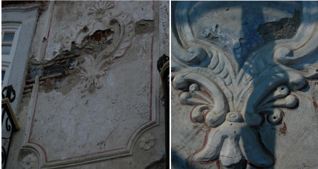
Figuras 5.57 e 5.58 - Recuperação de elementos da fachada (Antes e depois da intervenção).
