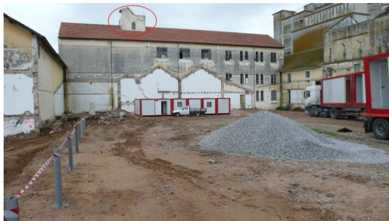
Figura 5.7 - Localização do torreão.
