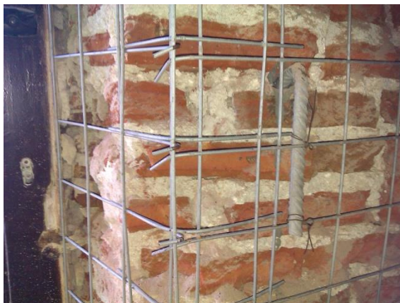
Figura 5.36 - Reforço das paredes através de pregagem por varões e malha.
