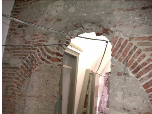
Figura 5.40 - Abertura de um novo vão.
