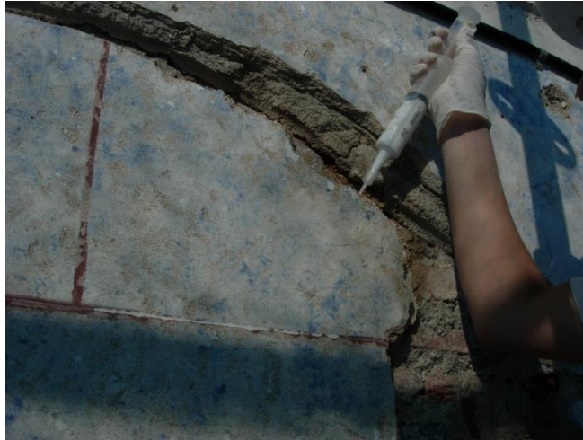
Figura 5.56 - Injeção de materiais com características consolidantes.
