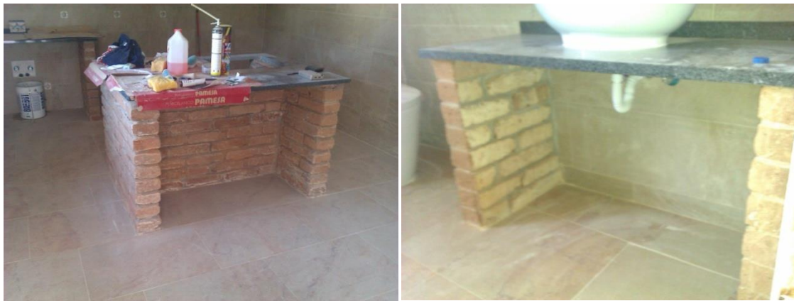
Figuras 5.27 e 5.28 - Reutilização de tijolos maciços em bancadas para a cozinha e casa de banho.
