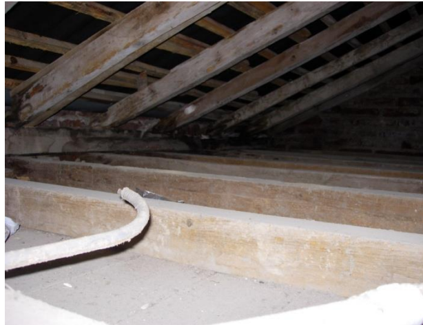
Figura 5.34 - Estrutura da cobertura.
