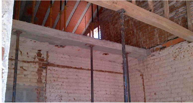
Figura 5.24 - Viga ao longo do vão.
