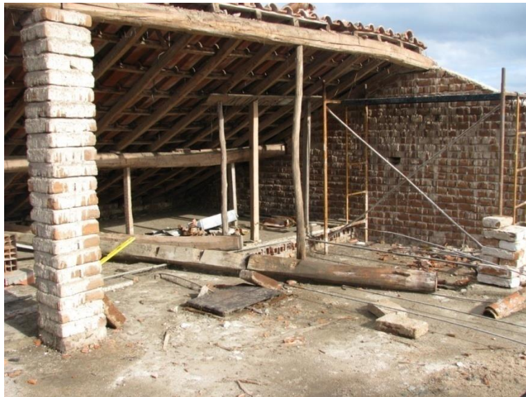
Figura 5.15 - Estrutura original da cobertura.
