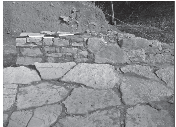
Figura 28 - Extremidade norte da guarda este da ponte. Repare-se na diferença do aparelho da guarda original (à esquerda, sob a escala), escavada nesta campanha, e da guarda reconstruída no século XX (à direita daquela).
