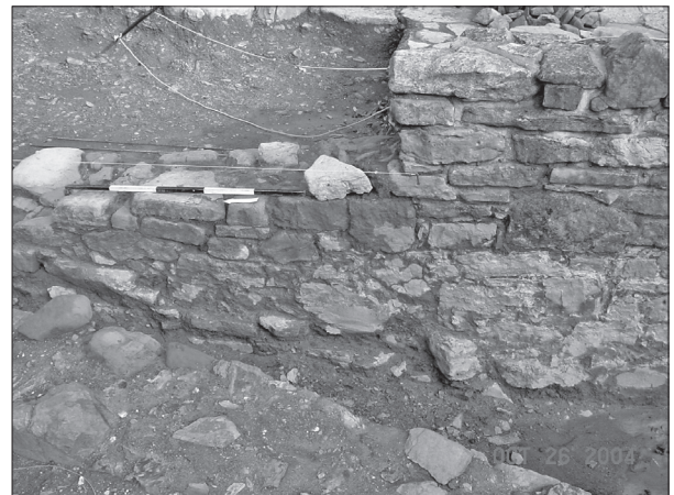
Figura 29 - Extremidade norte da guarda oeste da ponte. Repare-se na identidade do aparelho da guarda e do paramento.
