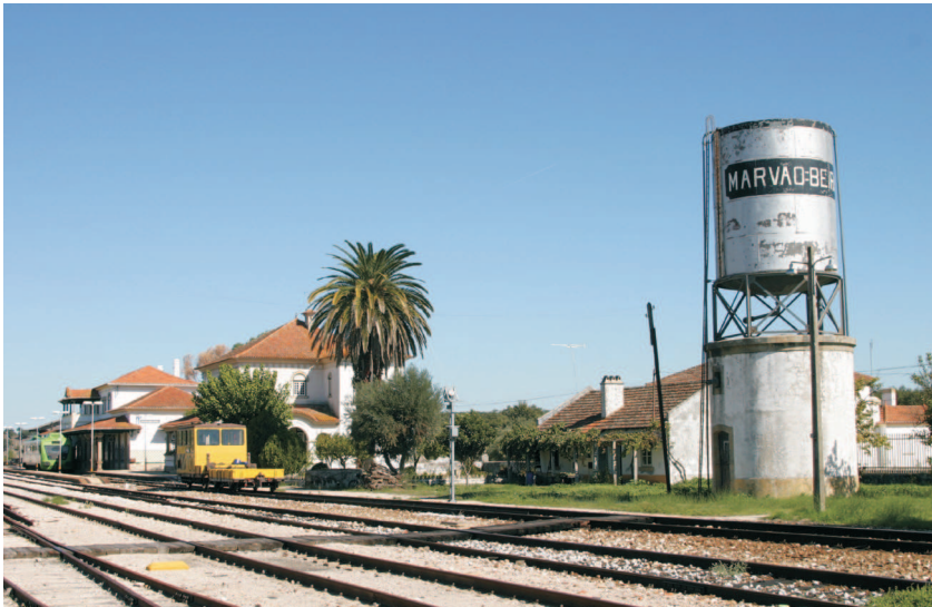
“...com a chegada da linha de caminho de ferro à Beirã a diversidade alimentar no concelho de Marvão regista um aumento substancial.”
