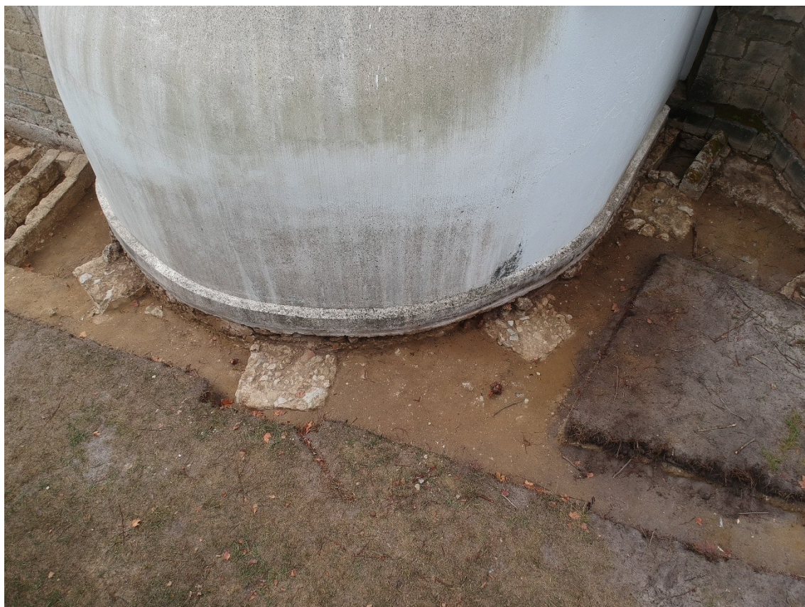
Imagem 26 - Contrafortes encontrados junto á abside do edifício (autoria: Rita Balona)
