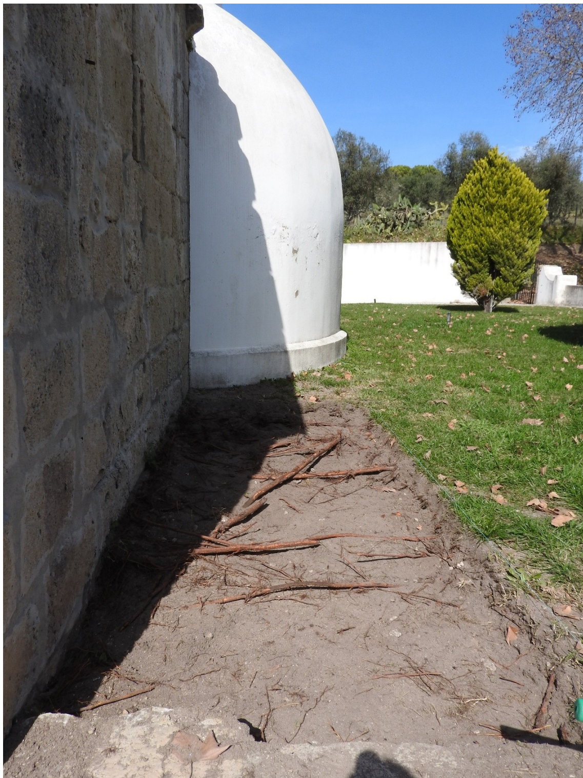
Imagem 9 - Escavação do exterior da Capela do Tesouro, Pormenor das raízes (autoria: Rita Balona)
