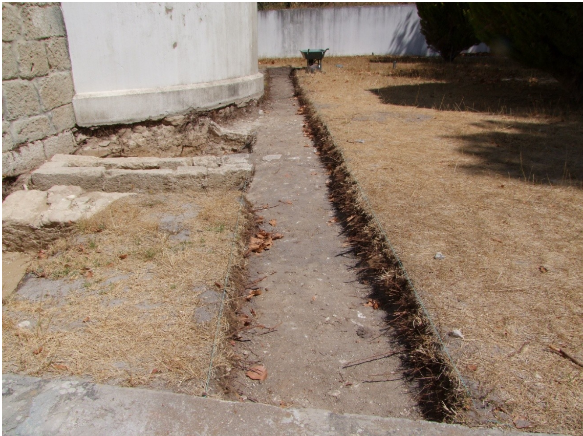
Imagem 25 - Abertura de vala para dreno no exterior do Santuário (autoria: Rita Balona)
