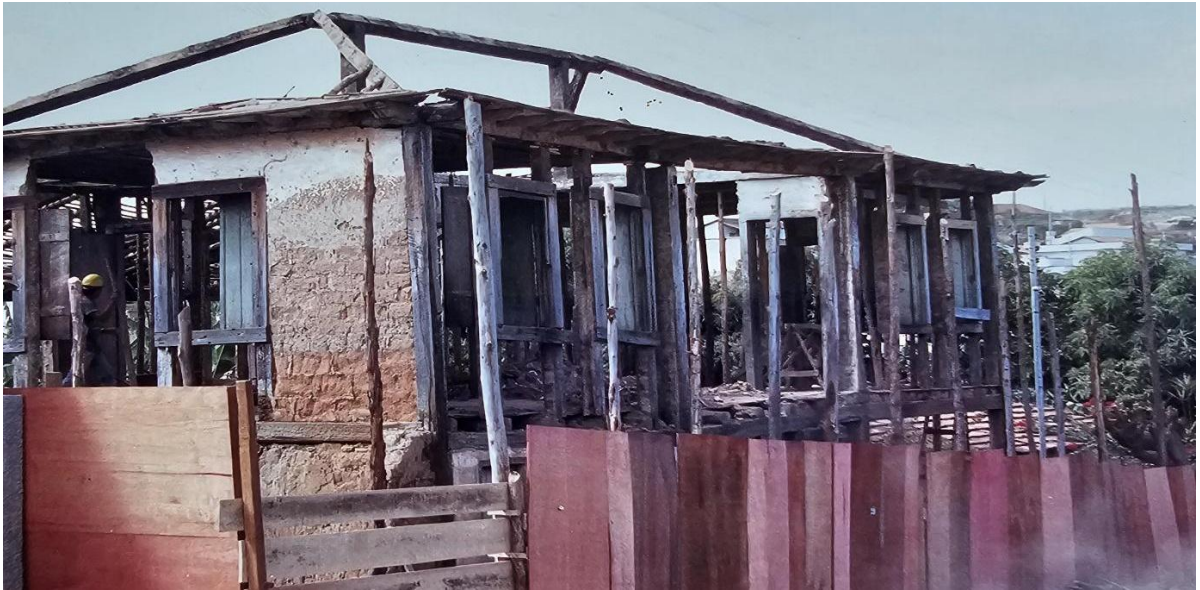
Figura 4: Imagem do sobrado em fase de restauro. Podemos ver que muitas paredes tiveram seus adobes retirados.
