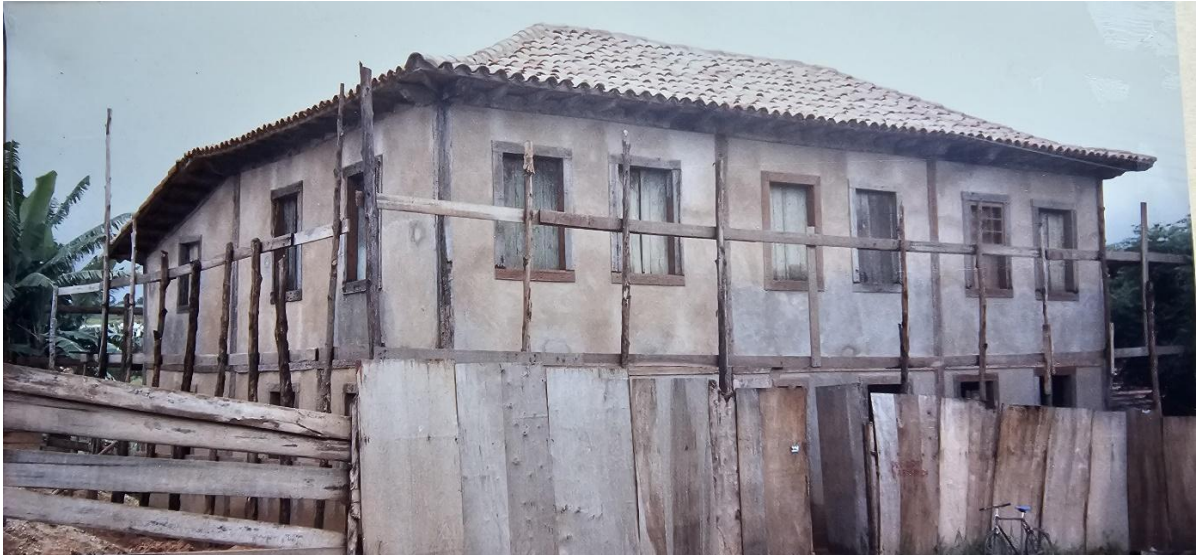
Figura 7: Restauro do sobrado com o preenchimento dos cheios e vazios com alvenaria e madeira. Acervo de Eyder Braga.
