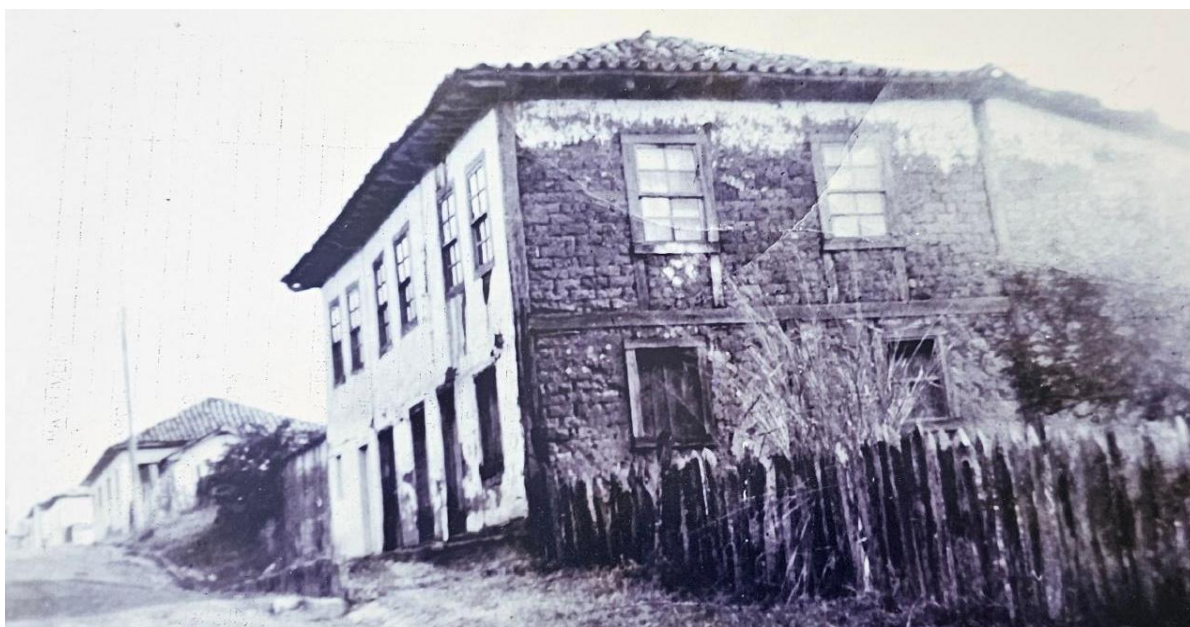
Figura 1: O sobrado e sua contextualização na paisagem do entorno. Vislumbramos sua construção na testada do lote, em altura um pouco elevada em relação ao nível da rua, desprovida de calçamento e de muros de adobe. O lote era cercado na frente por estacas de aroeiras fixadas ao chão de forma vertical. Acervo da Casa da Cultura.
