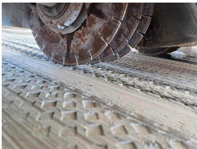
Figura 3.9: Detalhe dos disco existentes na multidiscos, estes podem ser colocados em várias posições, em função da largura das bandas que se pretende obter.
