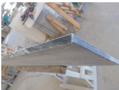
Figura 3.18: Exemplo de uma "cabeça" no comprimento do parapeito e numa das laterais. Assim como uma pingadeira no tardo.
