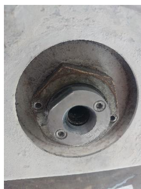
Figura 4.4: Rosca \frac{1}{2} gás para acoplamento de fresas manualmente.
