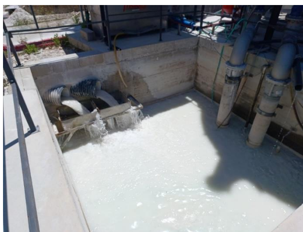
Figura 3.29: Poço coletor de águas industriais. A água vinda das instalações fabris entra no poço pelas duas tubagens da esquerda. No fundo, encontram-se duas bombas que encaminham a água para o depurador pelos dois tubos da direita.
