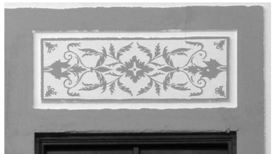
Fig. 35 O mesmo vão após ter sido objecto de uma intervenção acrílica de pintura dos esgrafitos – Rua 5 de Outubro, Évora.
