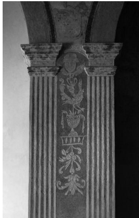
Fig. 22 Pormenor da pilastra - Igreja do Espírito Santo, Arronches.
