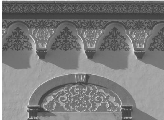
Fig. 25 Terreiro S. João de Deus, Montemor-o-Novo.
