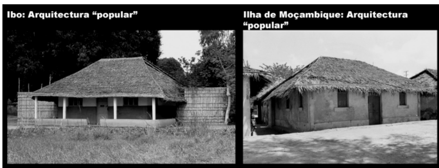
Figura 4 – Casas com paredes de alvenaria e cobertura de macuti (Fonte: Carrilho & Lage, 2011)
