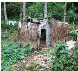
Figura 4- 35. Casa de banho da casa 10 com paredes de folha de coqueiro.
