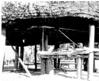
Figura 3- 19. Pilares de madeira sustentam o pavimento sobrelevado.
