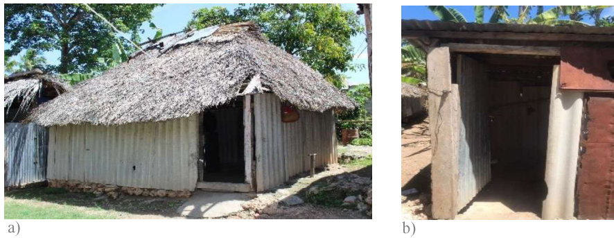
Figura 4- 19. Construções autónomas da casa 8. a) Cozinha b) Instalação sanitária.
