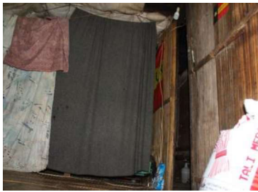
Figura 4- 36. Parede divisória com tecido. Casa 10.
