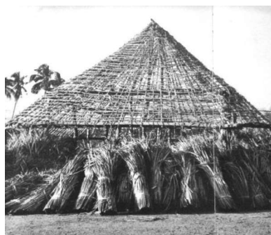
Figura 3- 21. Estrutura da cobertura.
