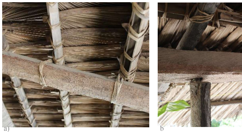
Figura 4- 49. Ligações dos materiais nas casas vernáculas em 2022. a) Ligação dos materiais com fibras vegetais b) Ligação dos materiais por entalhe.
