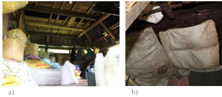
Figura 4- 42. Foro interior. a) Foro interior com bambu espalmado b) Foro interior com tela em branca casa 9 e casa 10.
