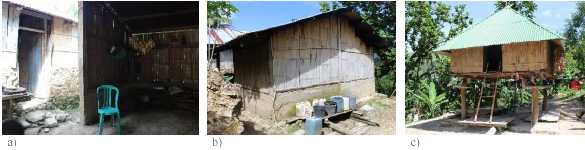
Figura 4- 27. Construções autónomas da casa 12. a) Porta posterior dá acesso à cozinha b) Cozinha c) Celeiro.
