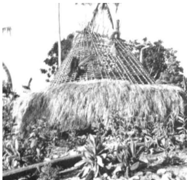
Figura 3- 10. Revestimento da cobertura com molhos de capim.
