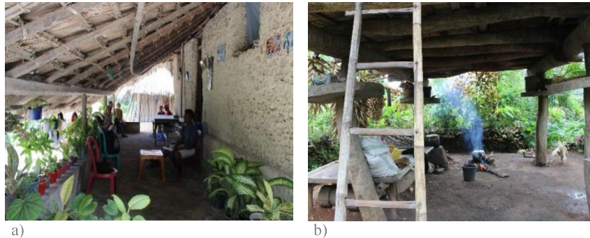
Figura 4- 62. Lugar de convívio social. a) Varanda da tipologia A b) Espaço inferior da habitação tipologia B.
