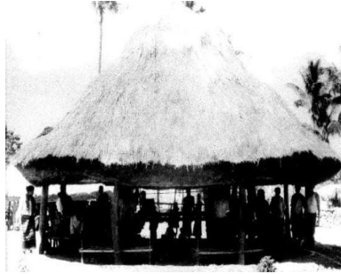
Figura 3- 16. Habitação da tipologia B com cobertura quase cónica.
