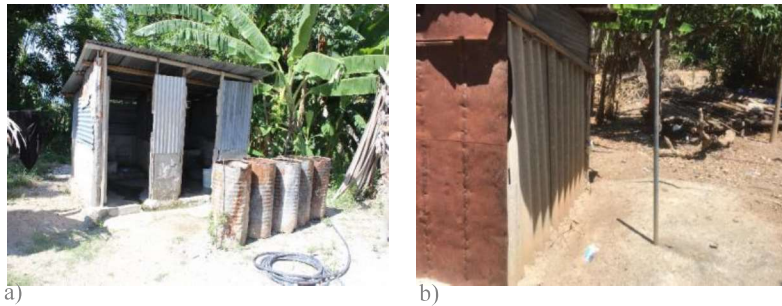
Figura 4- 53. Abastecimento de água e esgoto sanitário. a) Reservatórios da água junto a instalação sanitária b) Fossa séptica.
