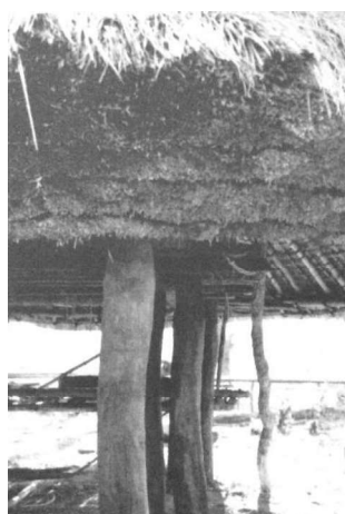
Figura 3- 18. Pilares de madeira.
