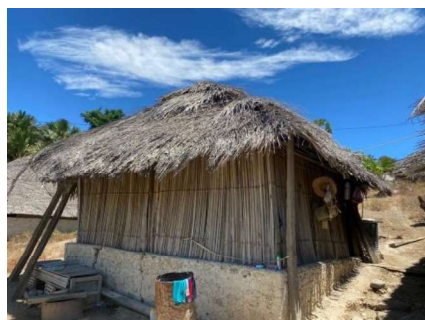
Figura 4- 11. Construção autónoma da casa 4. Cozinha.
