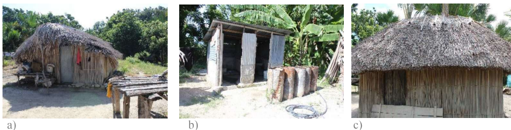
Figura 4- 6. Construções autónomas da casa 2. a) Segunda habitação b) Instalação sanitária c) cozinha
