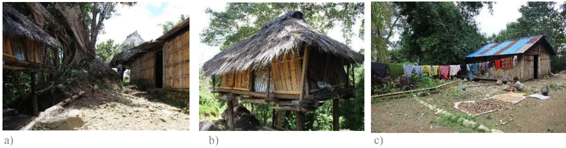
Figura 4- 15. Construções autónomas da Casa 6. a) Celeiro situado atrás da habitação b) Fachada do celeiro c) Cozinha.
