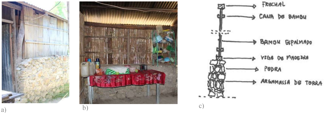
Figura 4- 31. Parede mista. a) e b) Parede mista de alvenaria de pedra e bambu espalmado. c) desenho em corte da parede.
