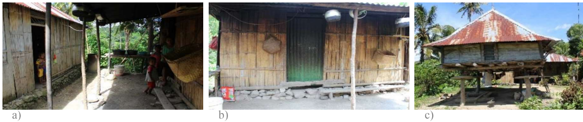
Figura 4- 25. Construções autónomas da casa 11. a) Porta posterior dá acesso à cozinha b) Cozinha c) Celeiro.
