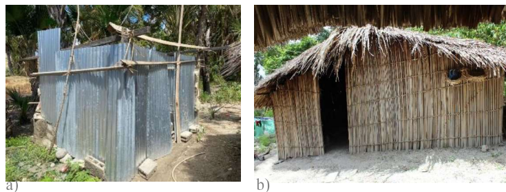
Figura 4- 8. Construção Autónoma da casa 3. a) Instalação sanitária (Inacabada). b) Cozinha.
