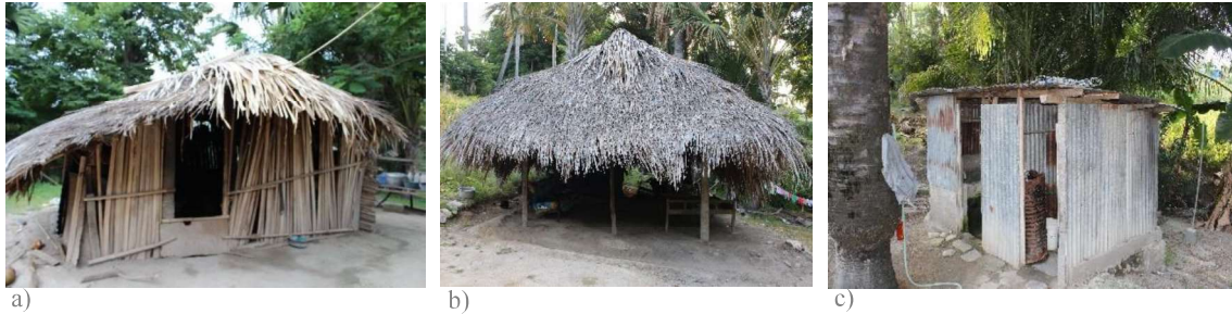
Figura 4- 13. Construções autónomas da casa 5. a) Cozinha b) Uma-Tali destinado ao lazer e local de trabalho c) Instalação sanitária.
