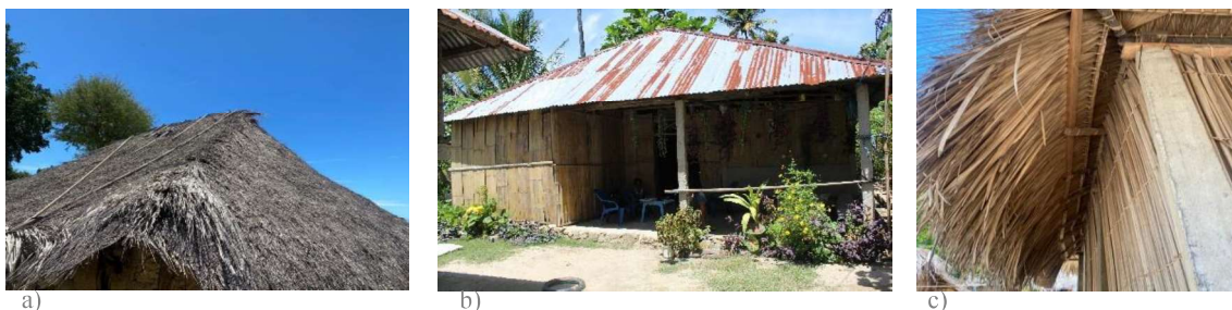
Figura 4- 39. Coberturas. a) Cobertura de folha de palmeira casa 7 b) Cobertura de zinco casa 11 c) Beiral casa 3.
