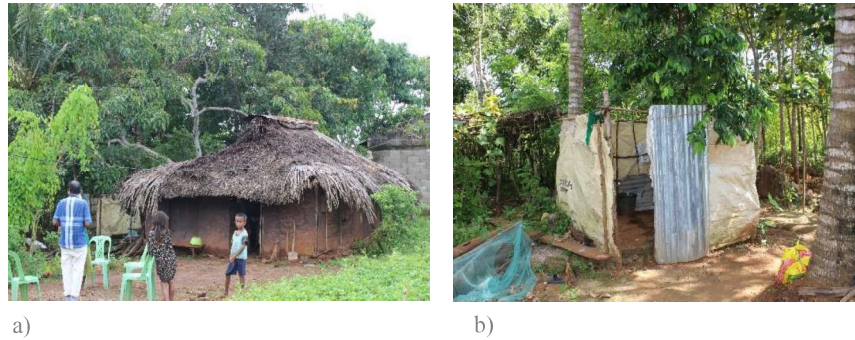
Figura 4- 17. Construções autónomas Casa 7. a) Cozinha b) Instalação sanitária.
