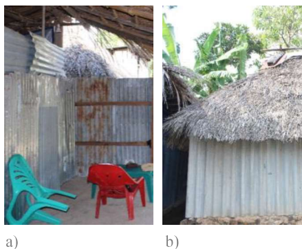
Figura 4- 37. Paredes em chapas. a) Parede em chapa de zinco b) parede em chapa de fibrocimento. Casa 8.
