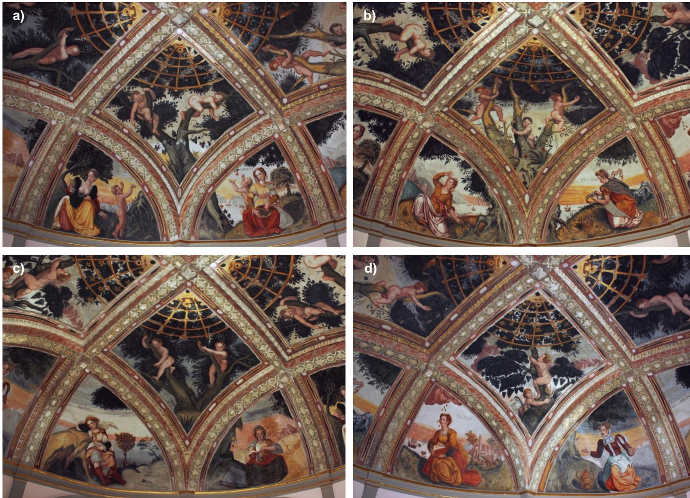
Figura 2.17 – Tecto da Sala Oval (PCB, Évora): a), b), c) e d) vista geral.
