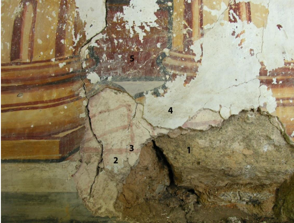
Figura 8.14 - Capela de Nossa Senhora do Rosário em Outeiro Seco, Chaves: Pormenor do altar onde se pode ver a estrutura de uma pintura, segundo a técnica descrita por Cennino Cennini: 1 - parede; 2 – arricio (emboço); 3 - desenho preparatório feito a pincel e tinta vermelha ( sinopia ); 4 – intonaco (induto); 5 - camada cromática.
