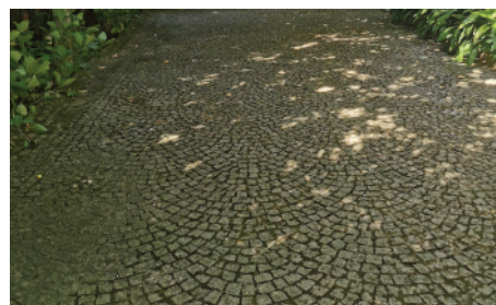
Figura 54 - Pavimento em microcubo de granito.
