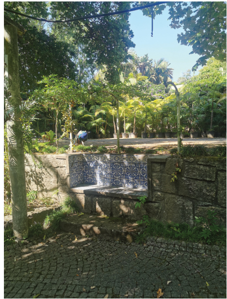
Figura 62 - Banco de betão azulejado.
