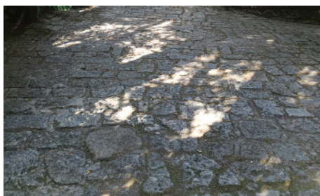
Figura 53 - Pavimento em blocos irregulares de granito.
