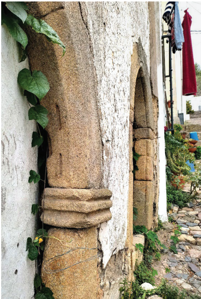
Porta com duas mezuzot junto à “Sinagoga” de Castelo de Vide.
