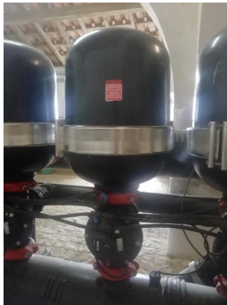
Figura 3.10 – Filtros de areia do sistema de rega.
