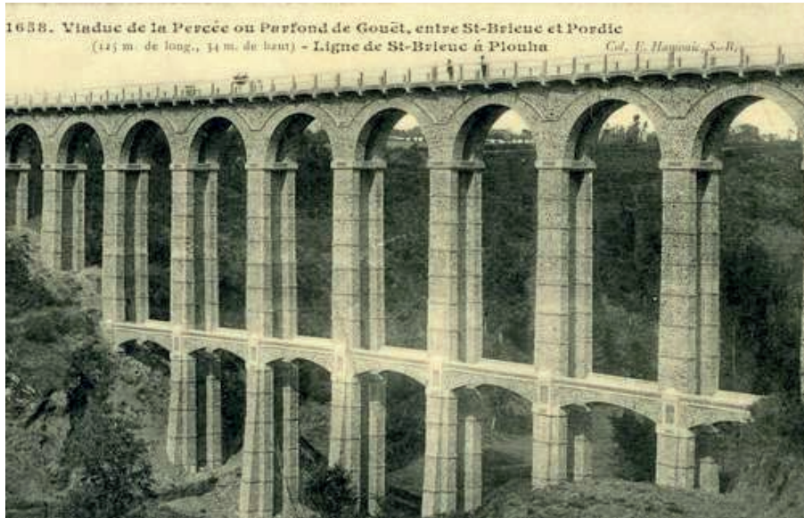
Fig. 4.- Viaduct of the Parfond du Gouët of the Chemins de Fer des Côtes-du-Nord 2010. Source: Wikipedia (Public domain).
