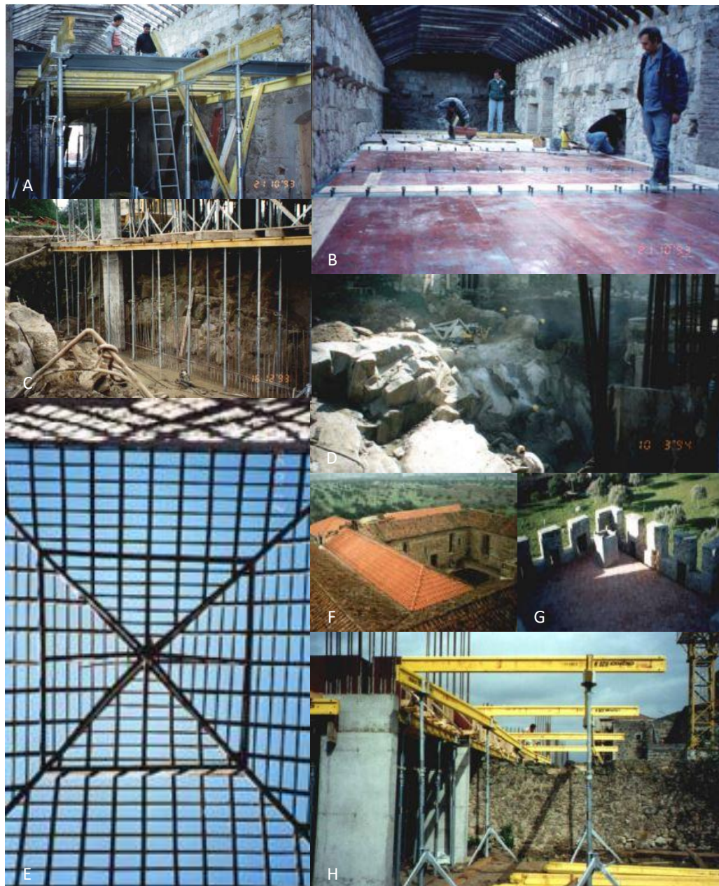
FIGURA 11- A PISO INTERMÉDIO (CONSTRUÇÃO DE DOIS QUARTOS): ESTRUTURA; B PISO INTERMÉDIO (CONSTRUÇÃO DE DOIS QUARTOS): COLOCAÇÃO DE PAVIMENTO; C CONSTRUÇÃO DA ALA NOVA; D ESCAVAÇÃO PARA CONSTRUÇÃO DO ELEVADOR; E CONSTRUÇÃO / RECUPERAÇÃO DE COBERTURAS; F RECUPERAÇÃO DE COBERTURAS; G RECUPERAÇÃO DA TORRE; H CONSTRUÇÃO DA ALA NOVA.
