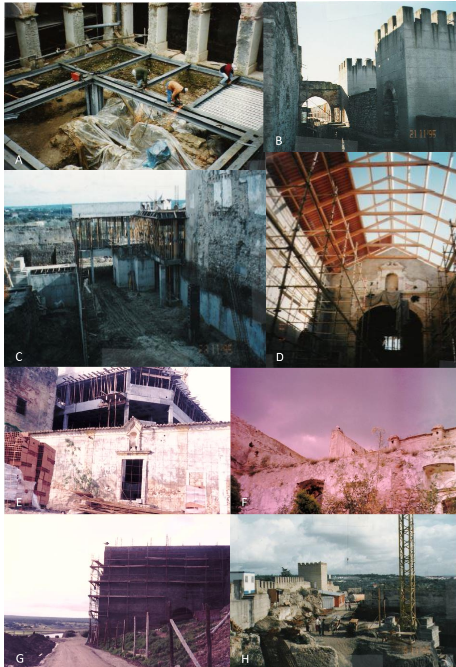
FIGURA 36- A CLAUSTRO / ESTRUTURA MUSEU; B CASTELO E MOSTEIRO: OBRA; C ARRANJOS NO MOSTEIRO; D ESTRUTURA DA COBERTURA DA IGREJA; E RECONSTRUÇÃO DA ZONA ESTE; F DEMOLIR HABITAÇÃO ABANDONADA; G RECONSTRUÇÃO DA MURALHA; H VISTA GERAL DA OBRA.
