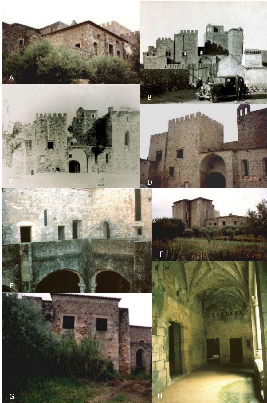
FIGURA 10- A EDIFÍCIO PRÉ-EXISTENTE. VISTA OESTE; B EDIFÍCIO PRÉ-EXISTENTE. FACHADA DO CONVENTO; C EDIFÍCIO PRÉ-EXISTENTE. FACHADA DO CONVENTO; D EDIFÍCIO PRÉ-EXISTENTE. FACHADA PRINCIPAL; E VISTA DO PRIMEIRO ANDAR PARA OS CLAUSTROS; F VISTA ESTE DO CONVENTO; G PORMENOR DE UMA ENTRADA LATERAL DO CONVENTO. VISTA NORTE; H PORMENOR DO CLAUSTRO.
