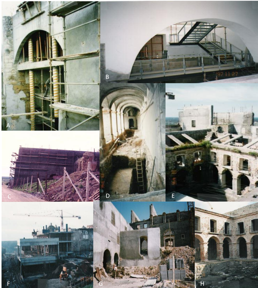
FIGURA 38- A RECONSTRUÇÃO DE UM DOS ARCOS; B OBRA: CORO-ALTO; C RECONSTRUÇÃO DA MURALHA; D CLAUSTRO: PISO 0; E CLAUSTRO / CONSTRUÇÃO NOVA; F RECONSTRUÇÃO DE UM DOS ARCOS; G CONSTRUÇÃO NOVA / MOSTEIRO; H CLAUSTRO / CONSTRUÇÃO NOVA.
