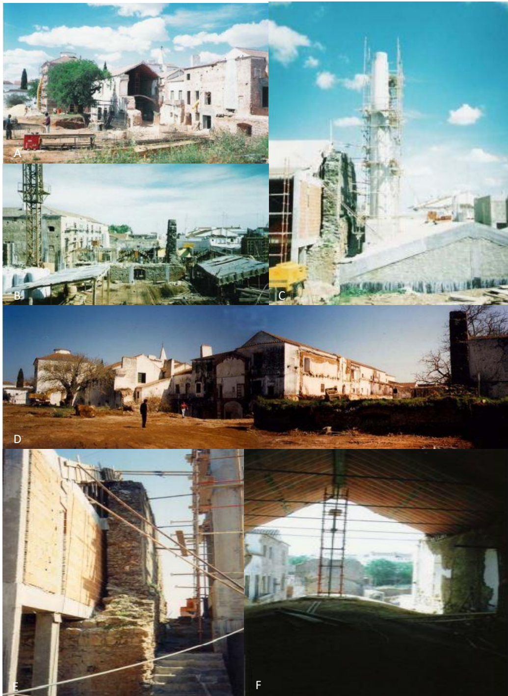
FIGURA 19- A VISTA EXTERIOR (LADO POENTE) E TORREÃO NORTE; B ALA NOVA. PAREDE EM RUÍNA E CHAMINÉS; C FACHADAS POENTE E SUL; D VISTA GERAL (LADO POENTE) E TORREÃO NORTE; E ALA NASCENTE / SUL; F ALA POENTE. VISTA INTERIOR.
