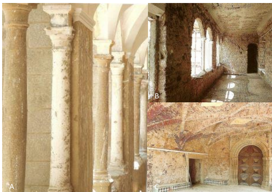
FIGURA 27- A EDIFÍCIO PRÉ-EXISTENTE. PORMENOR DAS COLUNAS DO CLAUSTRO; B EDIFÍCIO PRÉ-EXISTENTE. CORREDOR DO PRIMEIRO ANDAR NA ZONA DOS CLAUSTROS; C EDIFÍCIO PRÉ-EXISTENTE. ENTRADA.
