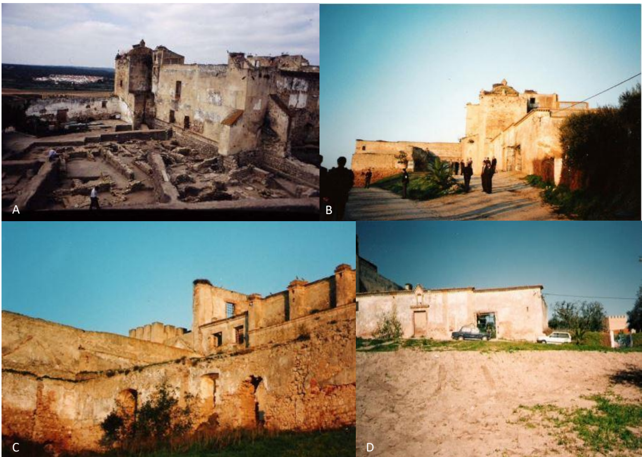
FIGURA 35- A ESCAVAÇÕES PERTO DO MOSTEIRO; B MOSTEIRO EM RUÍNA; C MOSTEIRO EM RUÍNA; D EDIFÍCIO EM RUÍNA.
