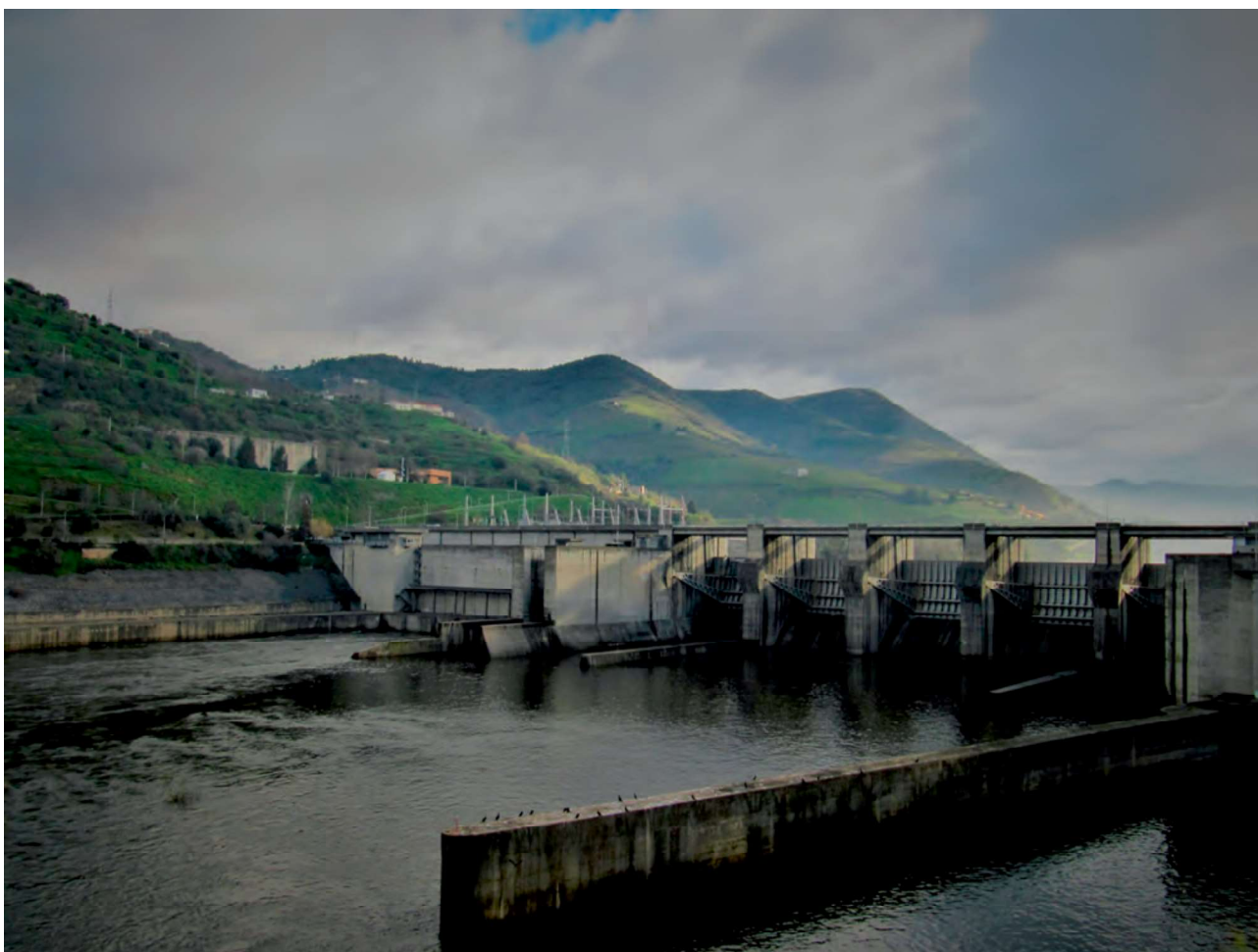
Vista de la presa de Bagaúste, sobre el río Duero. Autor: Paulo Travassos.
