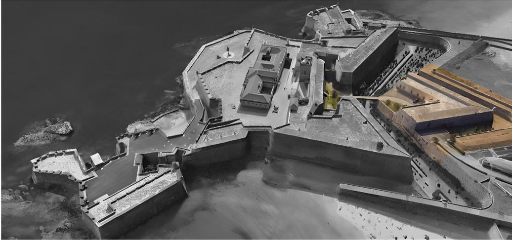
Fig. 89 | Identificação dos elementos construídos após a Restauração da Independência no complexo fortificado atual
