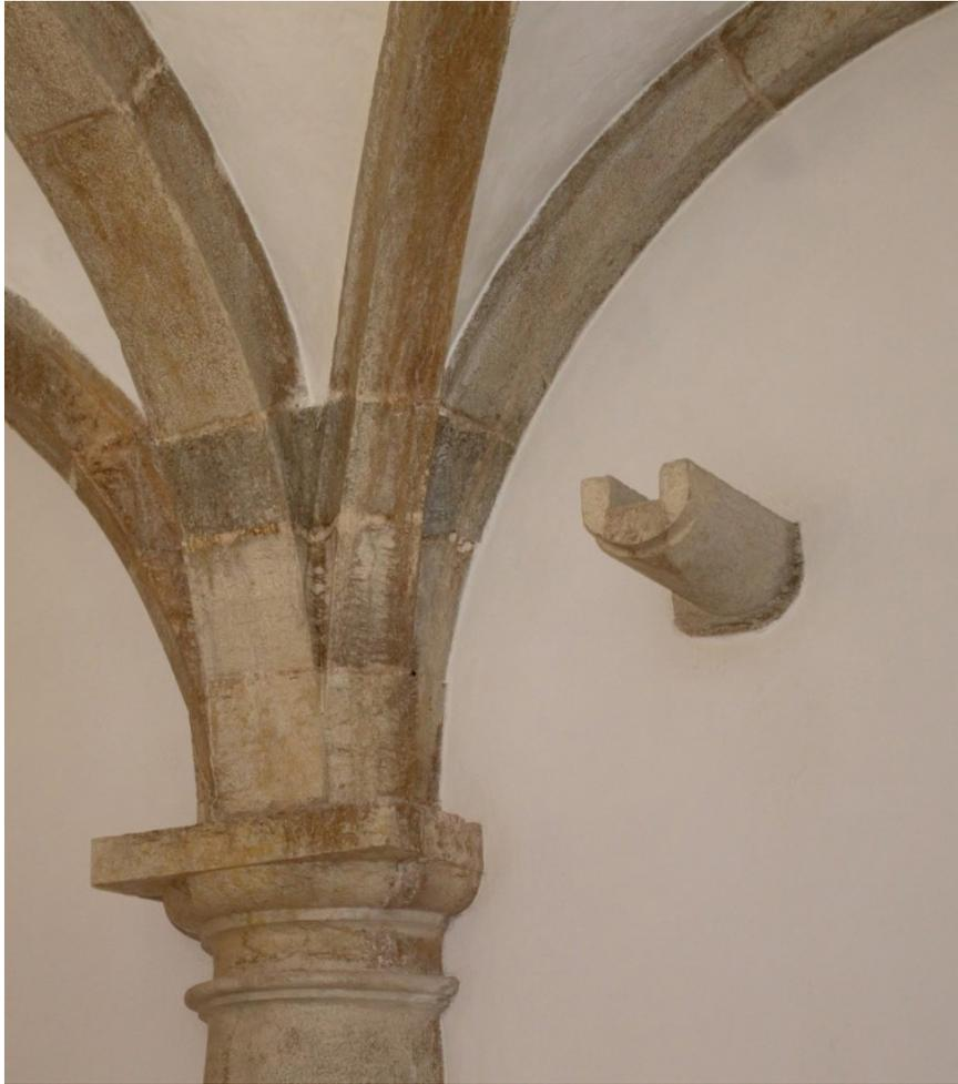
Fig. 30 | Uma das bicas por onde a água escorria para o interior da cisterna
