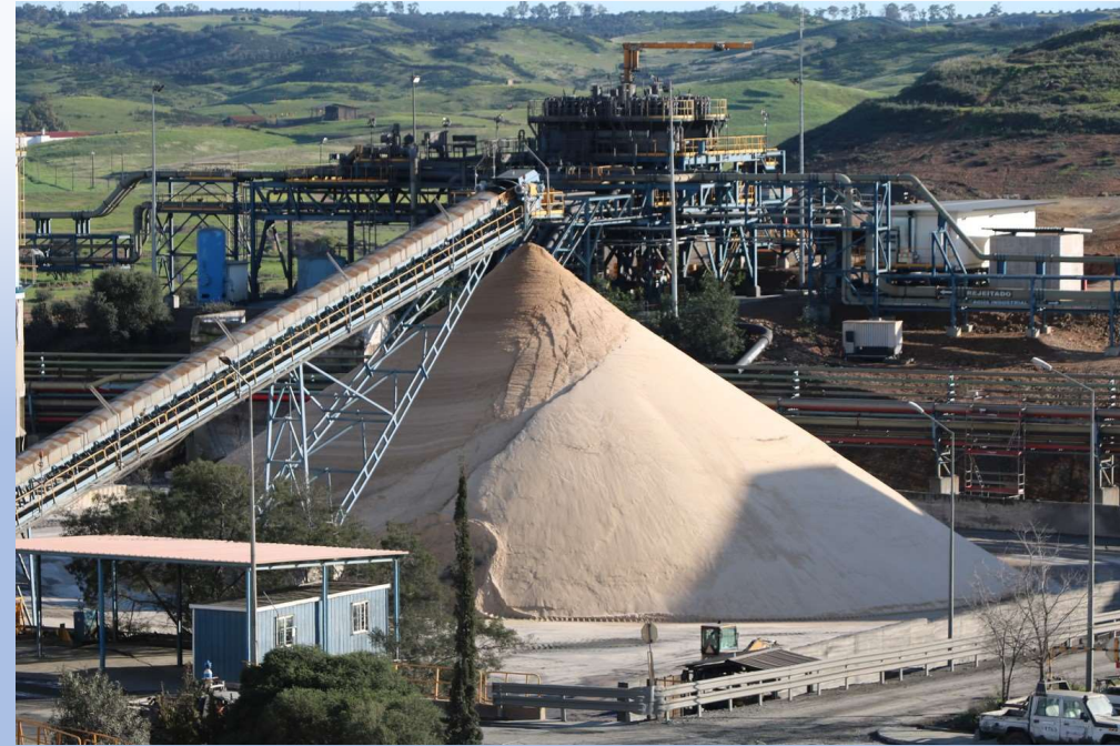
Central de enchimento / Filling unit Mina da Somincor
