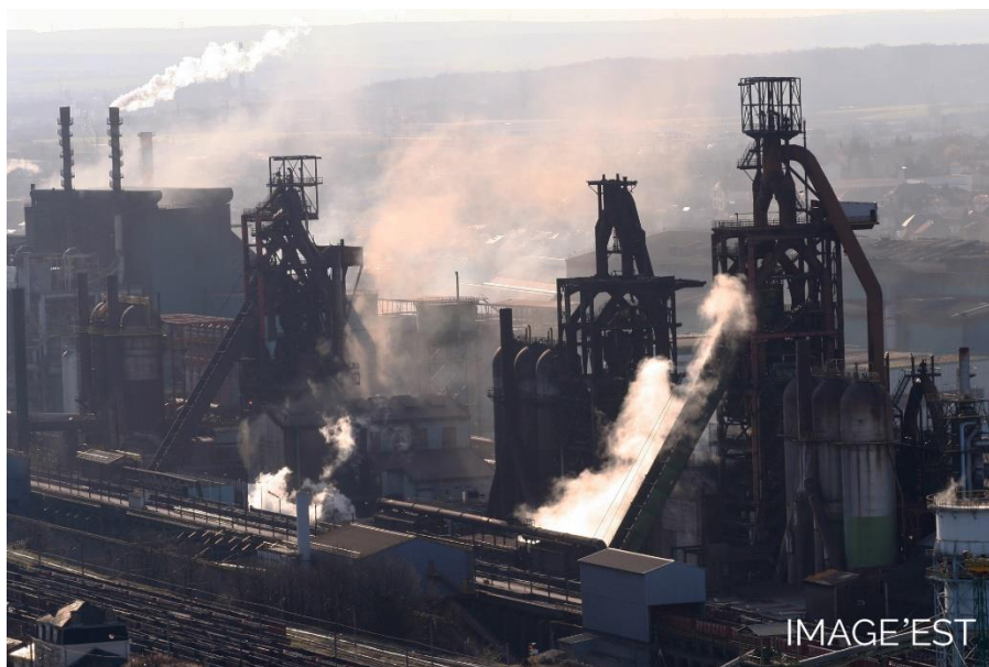
Figure n°32 : Hauts-fourneaux du Patural et aciérie Sollac (site Fenderie) en activité en 2009
