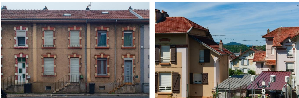
Figure n°4 : Exemples d'architectures des cités ouvrières.
