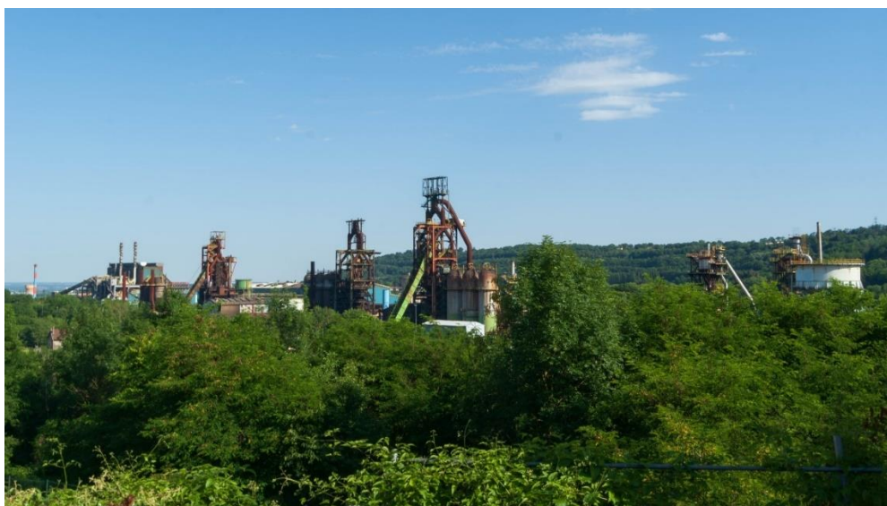
Figure n°30 : Vue générale de l'usine sidérurgique de Florange en 2022
