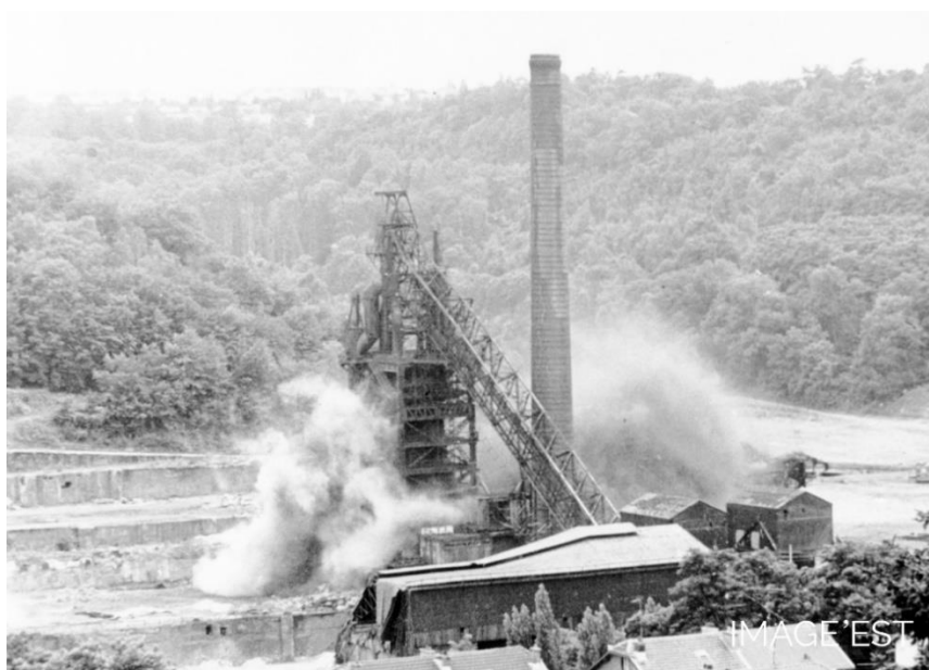
Figure n°25 : Dynamitage d'un haut fourneau de l'usine sidérurgique de Senelle à Longwy (Meurthe-et-Moselle)
