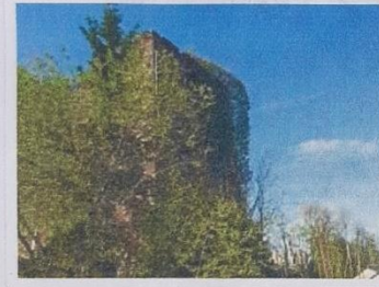
Tour-balance des mines de Mont-Saint-Martin
