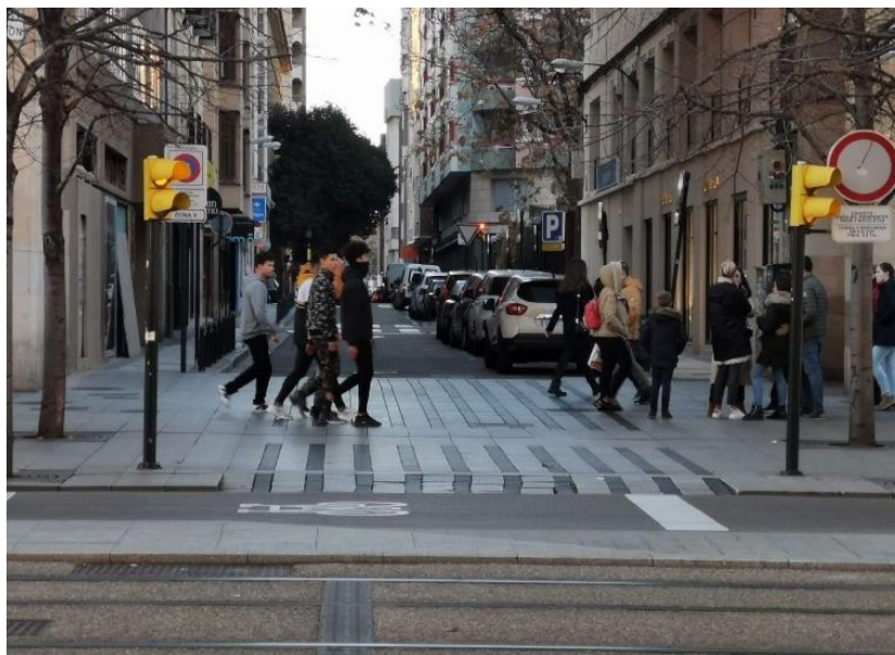
Figura 19 - Desenho do cruzamento em nível para o pedestre, Paseo Independencia. Fonte: fotografia elaborada pela autora, 10/12/2019.
