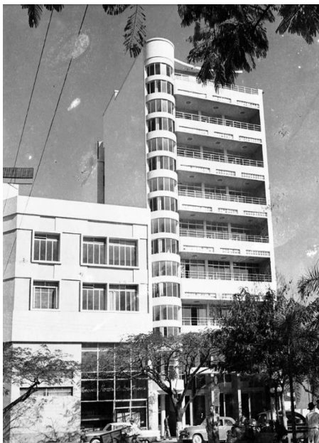
Figura 13 e 14 – Edifício Sandoval de Azevedo – 195. Fonte: Veiga Filho 2010 / Autor desconhecido.
