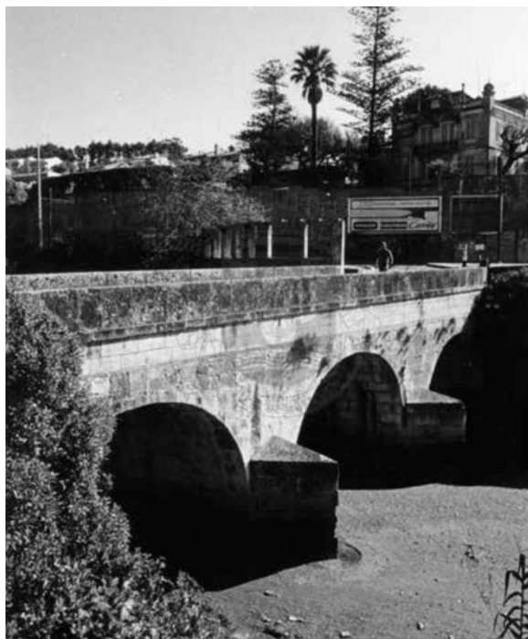
Figura 23 - Ponte da Cruz Quebrada. Autor e data desconhecidos. Consultado em: CMO (Ref: PT/MOER/MO/NF/008/000157);
