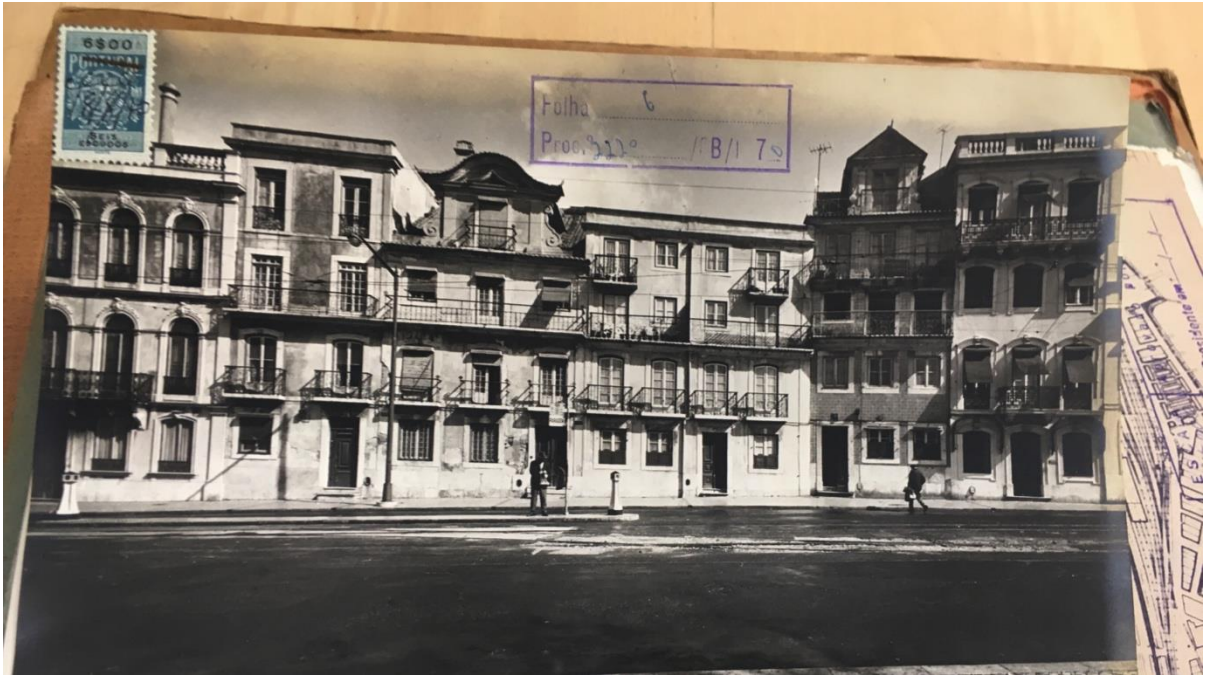
Figura 5 - Sinais de degradação presentes desde a década de 70. Consultado no Arquivo Municipal de Lisboa, Processo de Obra n.º 20724, Processo 2/20/B/1970.
