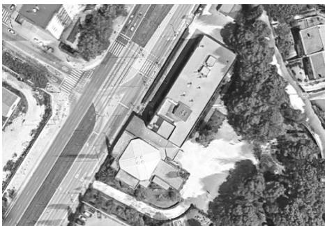
Figura 14. Ortofoto del estado actual del noviciado de las Salesianas.
