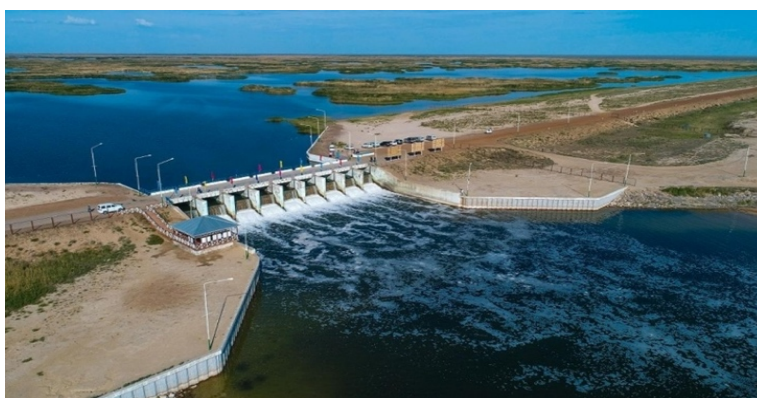
Figure 5.6. Barrage de Kokaral après l'achèvement de la construction en 2005.
