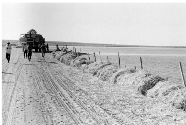
Figure 5.3. Construction du premier barrage dans le détroit de Berg, 1992
