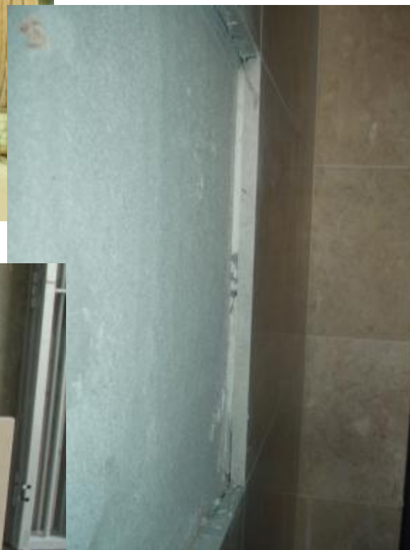
Colagem dupla com reforço (sistema de fixação misto)
