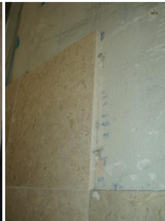
Colagem dupla com reforço (sistema de fixação misto)
