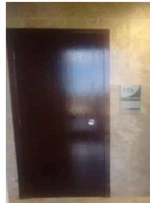
Figura 25 | Banheiro acessível STF. Fonte: Elaboração própria, 2018.
