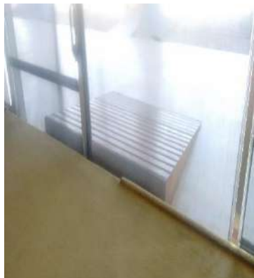
Figura 24 | Rampa colocada em uma das entradas em dia de sessão. Fonte: Elaboração própria, 2018.
