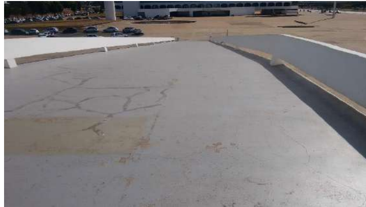
Figura 13 | Rampa principal do Museu Nacional. Fonte: Elaboração própria, 2018.
