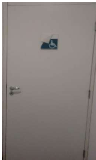
Figura 20 | Entrada do banheiro acessível. Fonte: Dados Primários, 2018.
