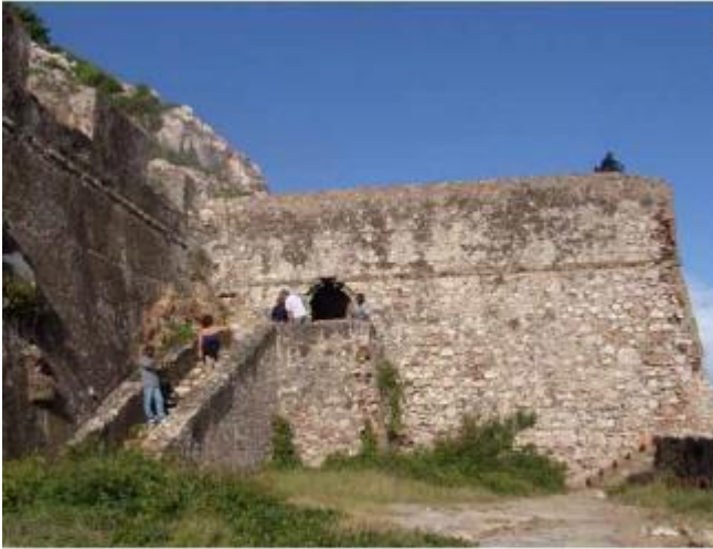
Figure 28- Galerie inférieure du Fort Picolet. Source : Archives Ispan 2009.
