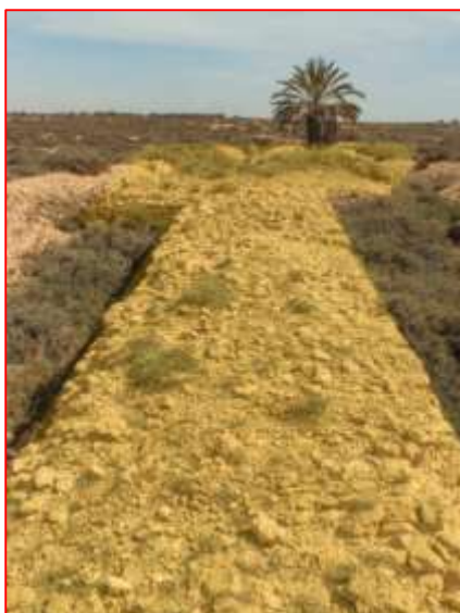
Figure 19: État actuel des remparts de Thaenae (Source auteur, 2020)
