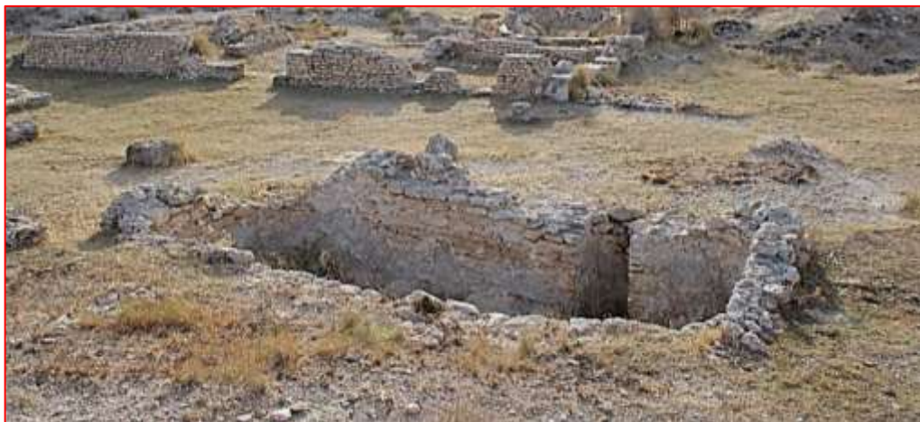
Figure 11: État actuel des citernes d'Acholla (Source auteur, 2020)
