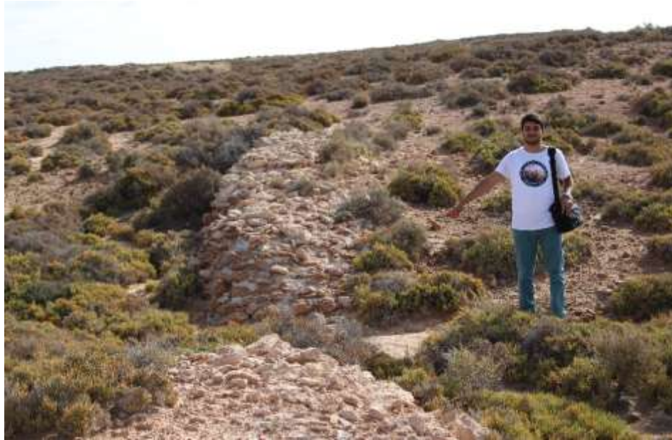
Figure 32: La destruction progressive des remparts (Source auteur, 2020)
