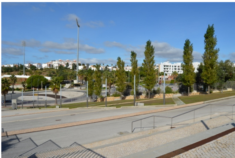
Figura 59 – Enquadramento visual e acesso ao edifício pelo acesso ponte
