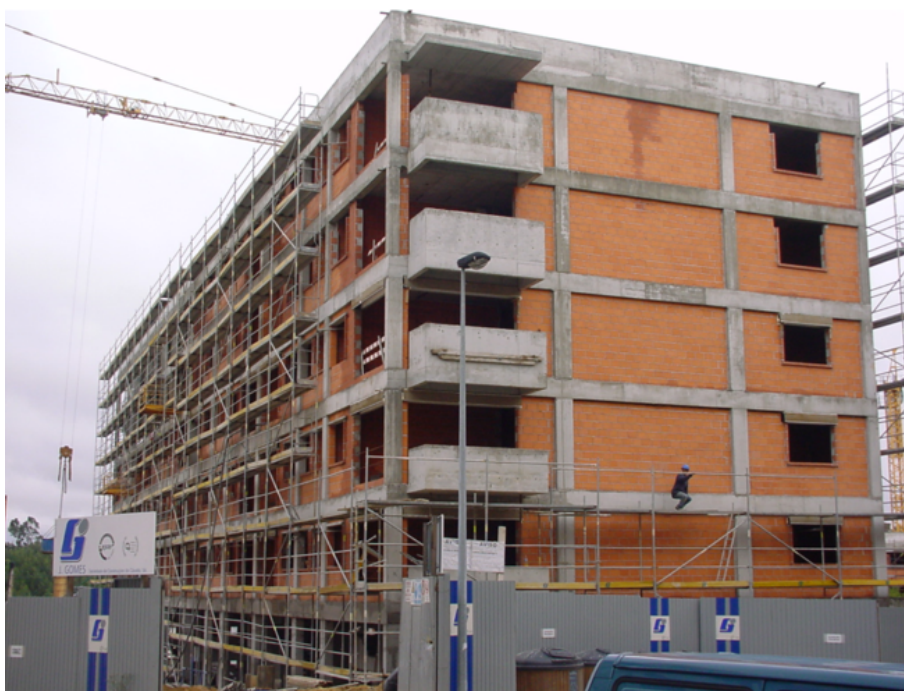
Figura 12 - Fotografia da construção da 2ª fase do conjunto habitacional da Ponte da Pedra, Retirado de http://www.lidera.info/?p=MenuContPage&MenuId=19&ContId=27
