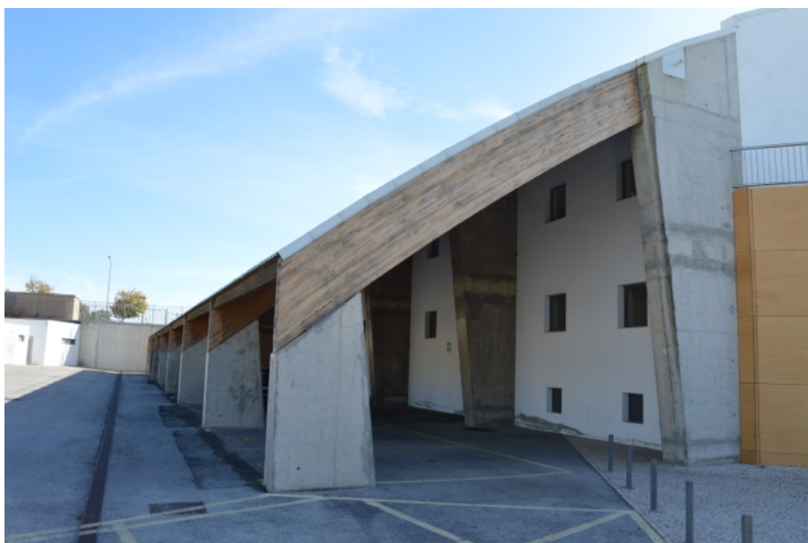
Figura 68 – Vista da fachada norte
