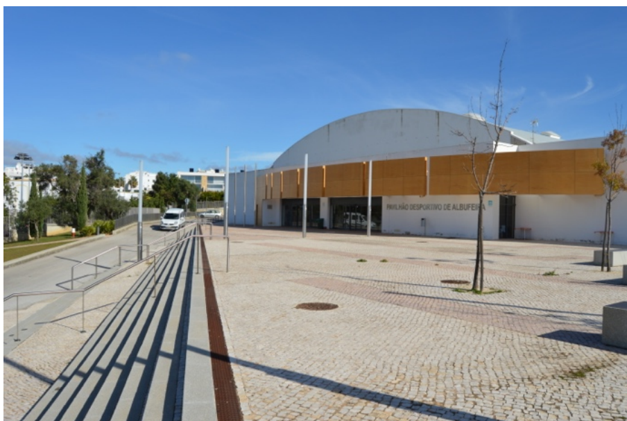
Figura 60 – Vista exterior da fachada principal a ponte
