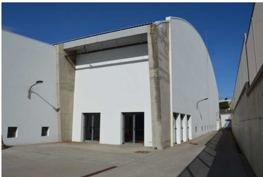
Figura 67 – Vista da fachada nascente
