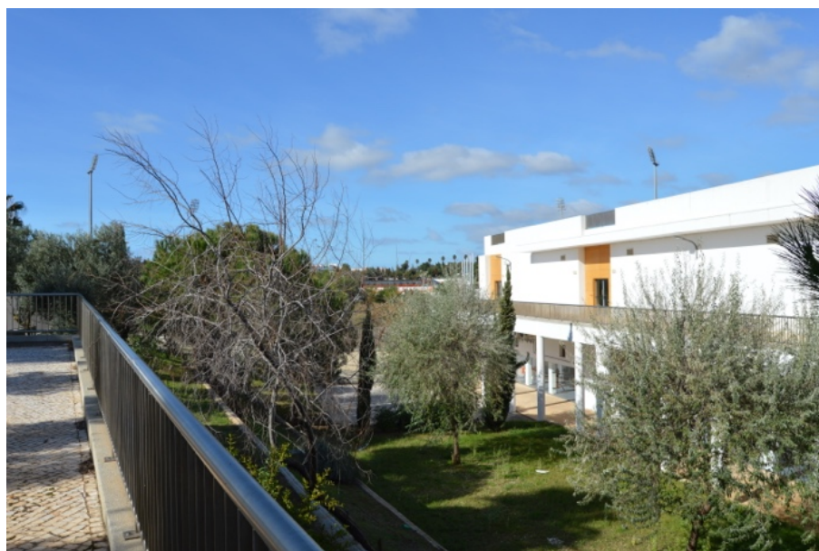
Figura 64 – Vista do espaço verde adjacente a sul do edifício
