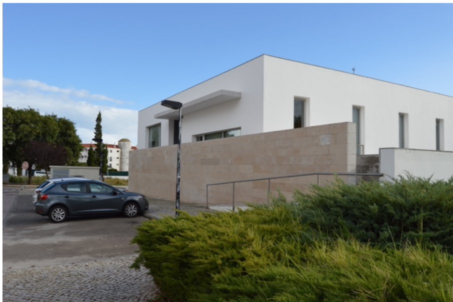
Figura 34 – Vista da fachada norte da Biblioteca
