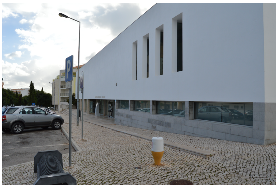
Figura 38 -Vista exterior da fachada principal do edifício
