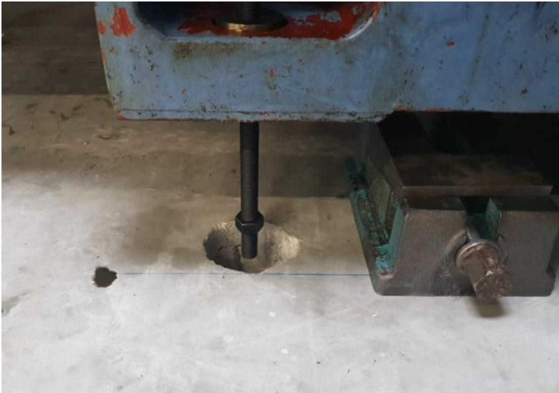
Figura 2.4-2 Colocação do varão roscado.
