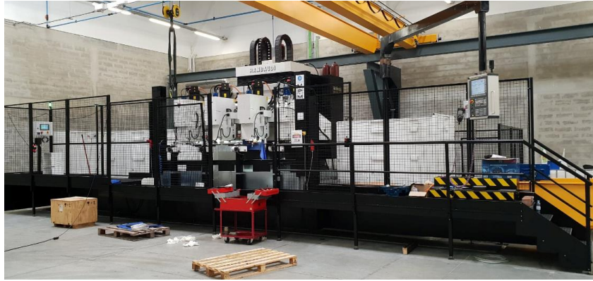
Figura 2.3-6 Instalação final da Rambaudi.
