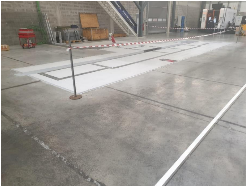
Figura 2.3-4 Aplicação de resina epóxi.
