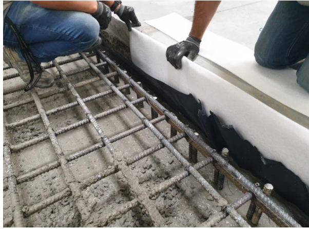
Figura 2.5-4 Colocação do isolamento e do betão.
