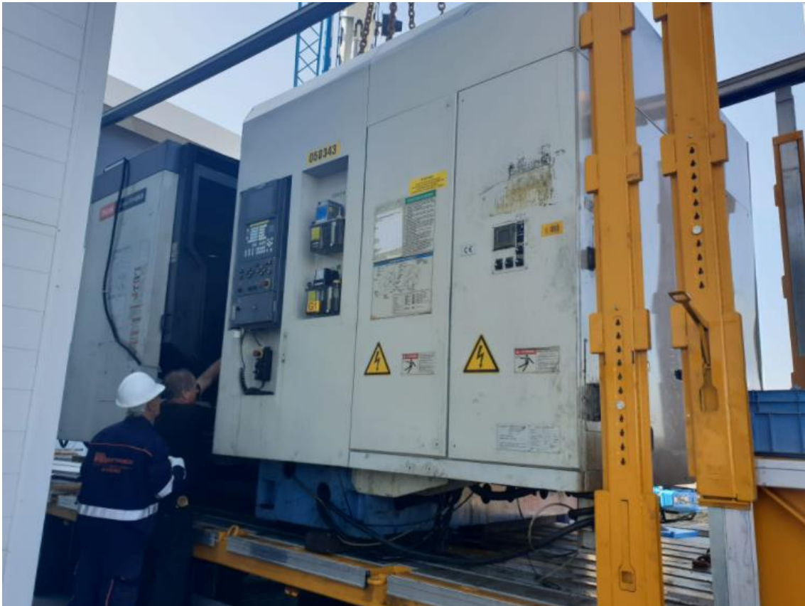
Figura 2.4-1 Descarga da FH6800 do camião.
