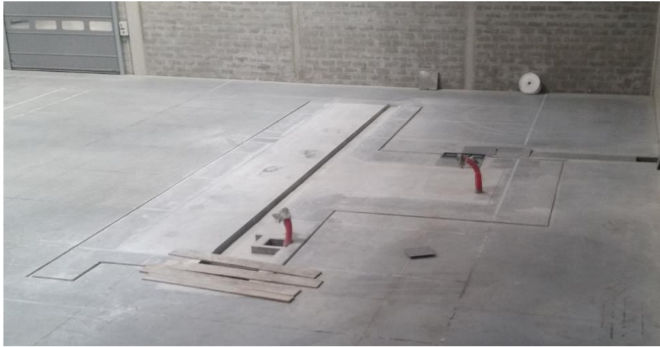
Figura 2.3-3 As fundações para a Rambdaudi.
