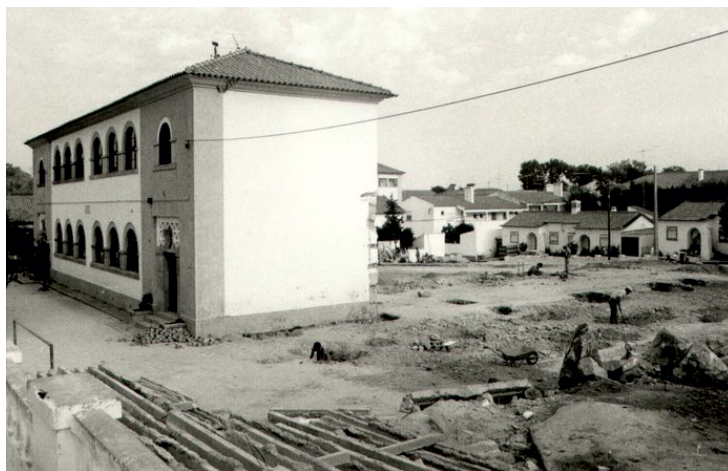
Fig. 15: Ampliação da cantina escolar (15)
