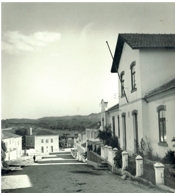
Fig. 19: Edifício escolar da Beirã
