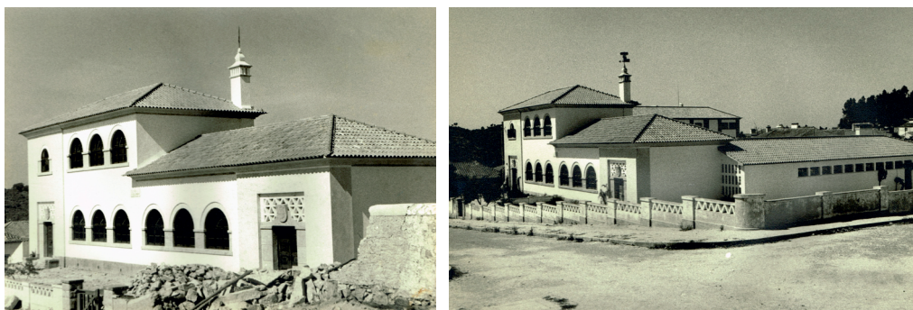
Fig. 8 e 9: Ampliação da escola primária de S.A.A (12)
