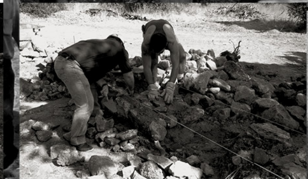
Reconstituição dos muros
