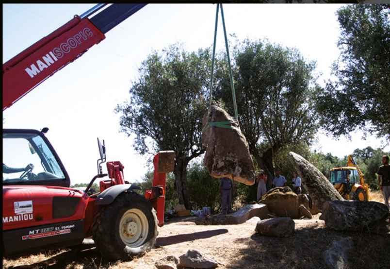
Montagem de esteio da Anta da Soalheira
