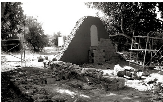
Construção do altar da igreja
