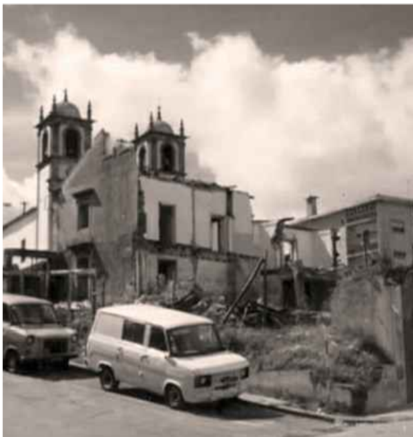
81. Demolição Pensão Avenida, 19--. FONTE: http://pazemeis-no-passado.blogspot.pt .
