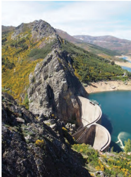
Figura 6 – Aspeto da crista quartzítica, na travessia do rio Unhais, onde foi implantada a barragem de Santa Luzia.
