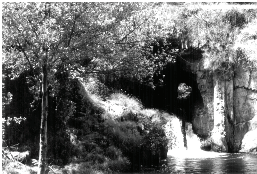
Figura 9 – Túnel do Vale Pardieiro, no rio Ceira, visto de jusante. Notar, à esquerda, encoberta pela árvore, a parede da construção onde funcionava um moinho, que aproveitava o desnível produzido pela queda de água. A “luz ao fundo do túnel” corresponde à abertura situada a montante.
