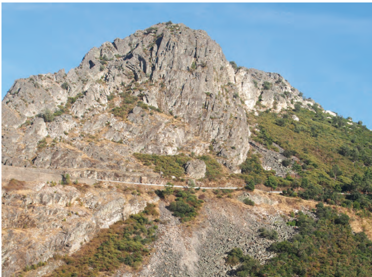
Figura 3 – Aspecto de pormenor da crista quartzítica no Cabeço do Soito e da imponente escombreira de gravidade que originou a jusante da barragem de Santa Luzia.
