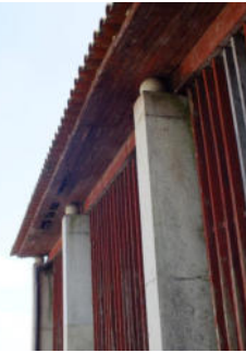
Fig. 2: Instalações Agrícolas do Louro
